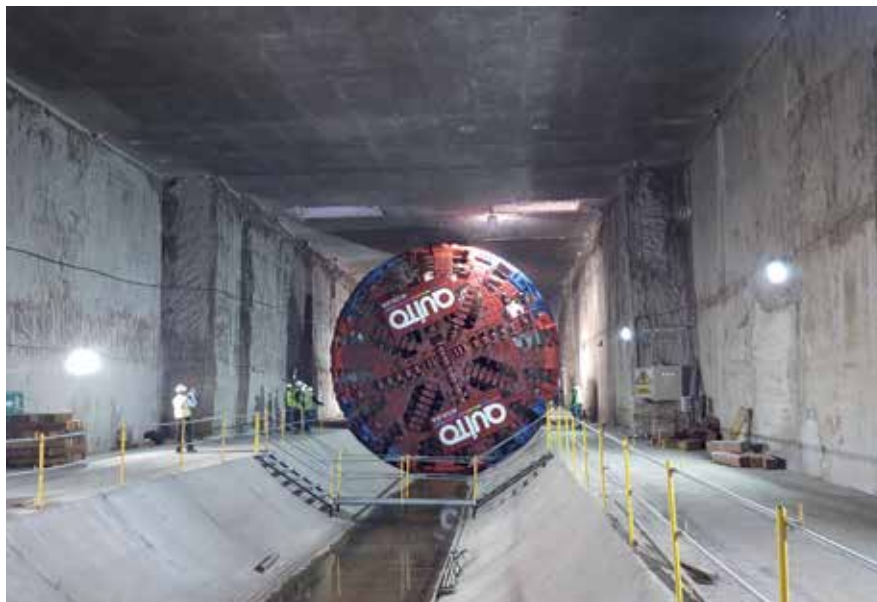
Construcción del metro de Quito
