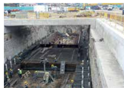
Construcción del metro de Quito
