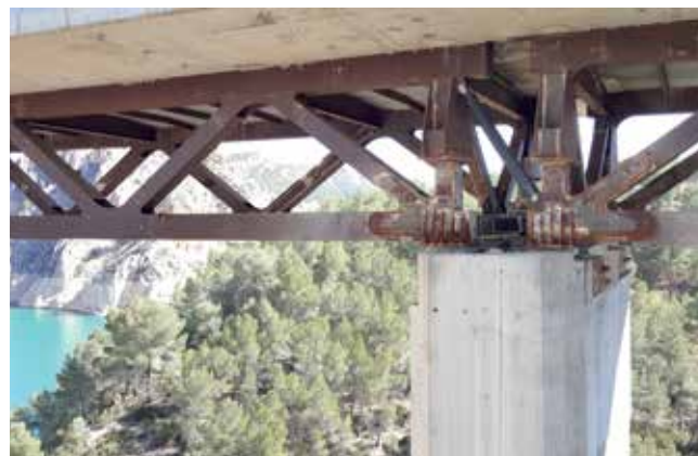
Fig. 3. Viaducto de Contreras (Valencia)
