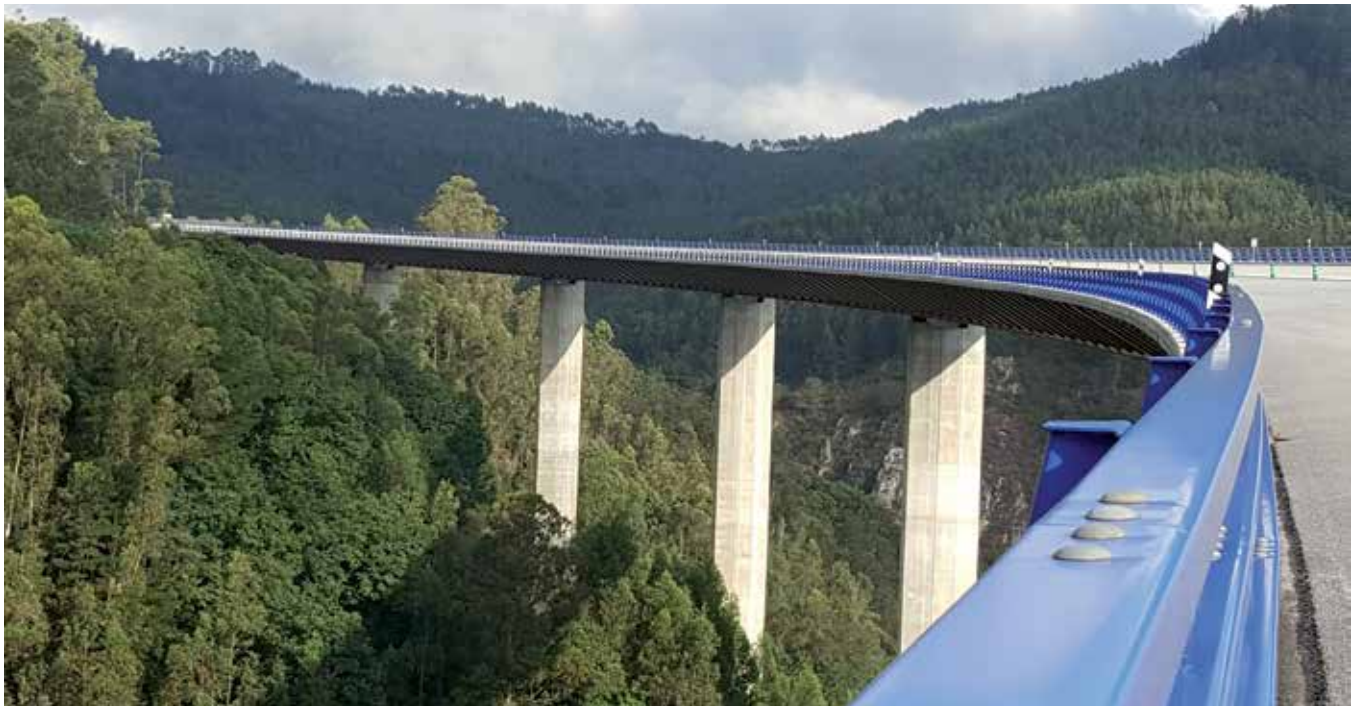
Fig. 1. Viaducto del Regueirón (Asturias)
