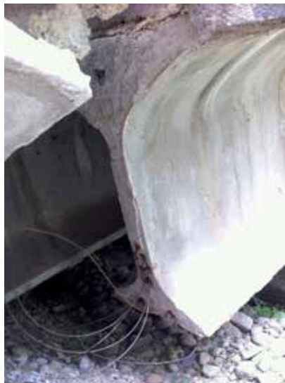
Fig. 13. La rotura de la viga de borde: detalles del modo de rotura, la corrosión de los alambres y la junta de 14 mm de mortero de “supercemento”
