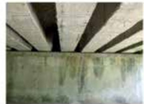
Humedades y filtraciones, librería 8, en Elemento M.F. portante del Componente E1 (Deterioro 18)
