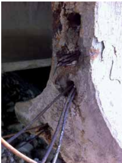
Fig. 13. La rotura de la viga de borde: detalles del modo de rotura, la corrosión de los alambres y la junta de 14 mm de mortero de “supercemento”
