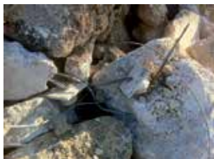
Fig. 17. Dispositivos de anclaje de vigas y losa
