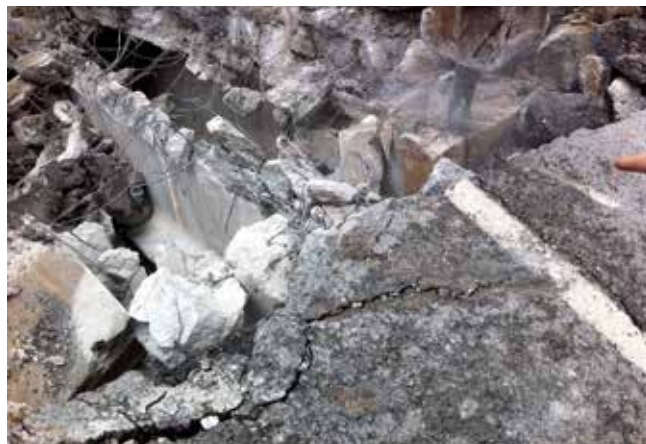
Fig. 15. Demolición del puente, el 15 de junio de 2015
