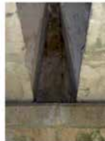
Humedades y filtraciones, librería 1, en Elemento Murete de guarda del Componente E1 (Deterioro 17)
