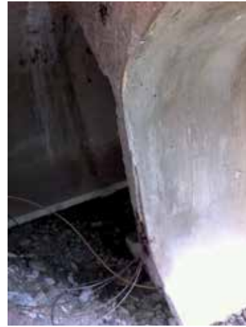
Fig. 22. La mala ejecución de las juntas y la deficiente inyección de las vainas precipitaron la corrosión de los alambres
