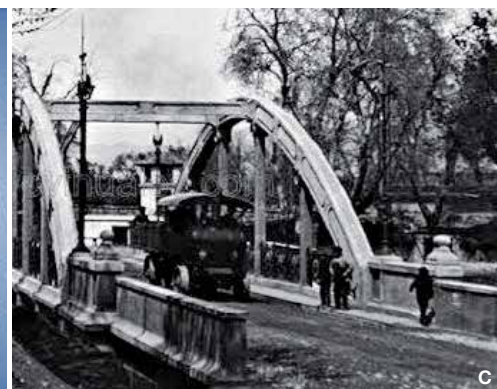
Fig. 14. A. Postal antigua del Puente San Miguel, que aparece claramente tangente al ábside; B. Reseña de prensa de la Recepción Oficial, 1913, que explica las 'pruebas estáticas' efectuadas con cargas de 80 Tm; C. 'Prueba dinámica' al paso de un vehículo, en la entrega de la Obra (Fototeca DPHu).
