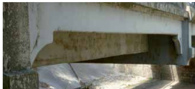
Fig. 13. Fotos de viga traviesa, y de viguetas-larguero, que forman en conjunto, la losa del tablero. La de borde de menor canto, y a continuación la de andén con mayor por el desnivel, y la central o de calzada. En primer término, el larguero de borde, muestra una grieta en la escuadra, que le une a la traviesa
