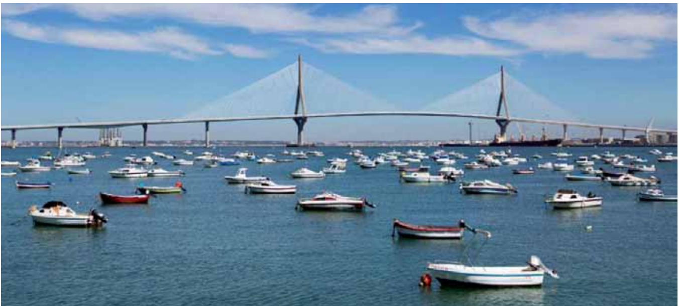
Puente de la Constitución de 1812 (Bahía de Cádiz)
