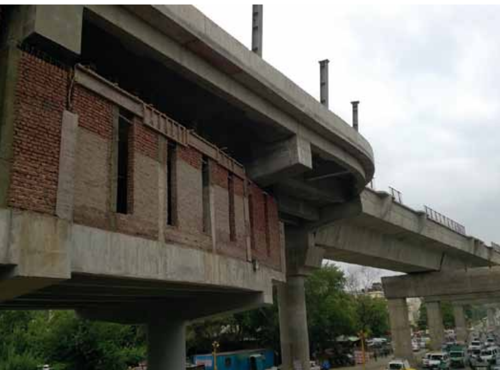
Construcción del metro de Delhi (Ayesa)
