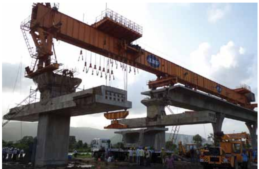
Construcción del metro de Mumbai (San José)
