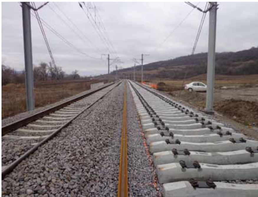
Infraestructura ferroviaria (Azvi)
