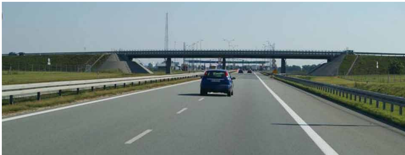
Autopista Arad-Timisoara (FCC)
