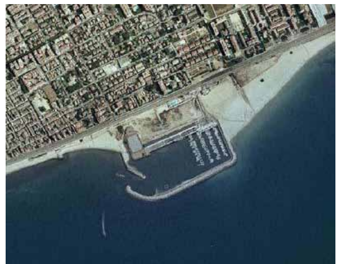
Puerto Premiá Retención de arena
