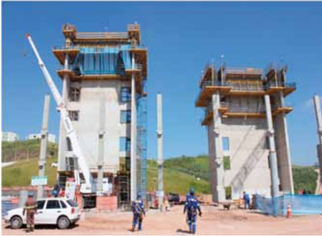
Fig. 4. Construcción de núcleos verticales mediante encofrados trepantes
