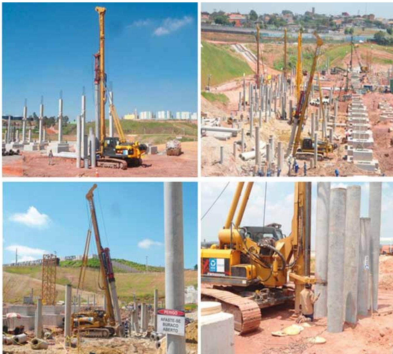
Fig. 3. Construcción de la cimentación de la zona oeste
