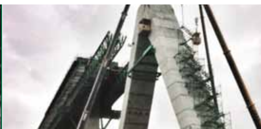
Puentes y Viaductos
