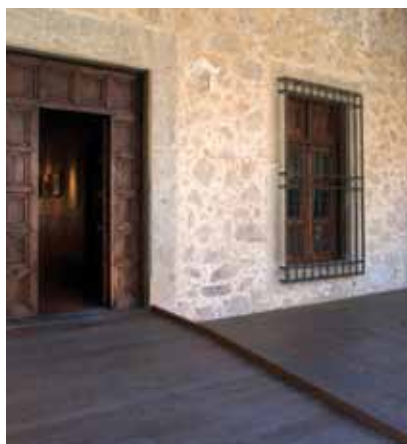
Entrada al Palacio del Emperador
