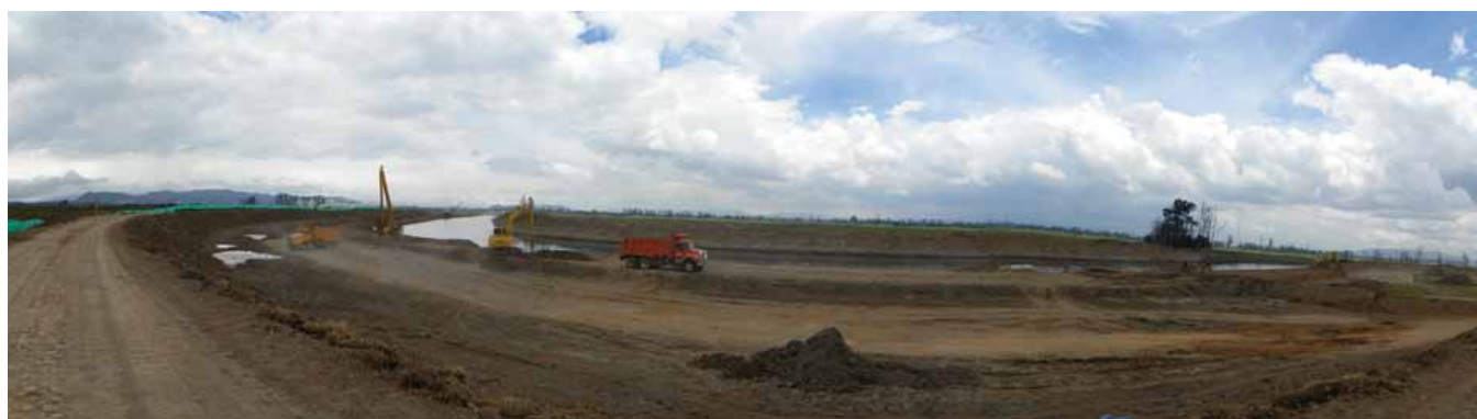
Realización de trabajos que se prolongarán hasta 2015
