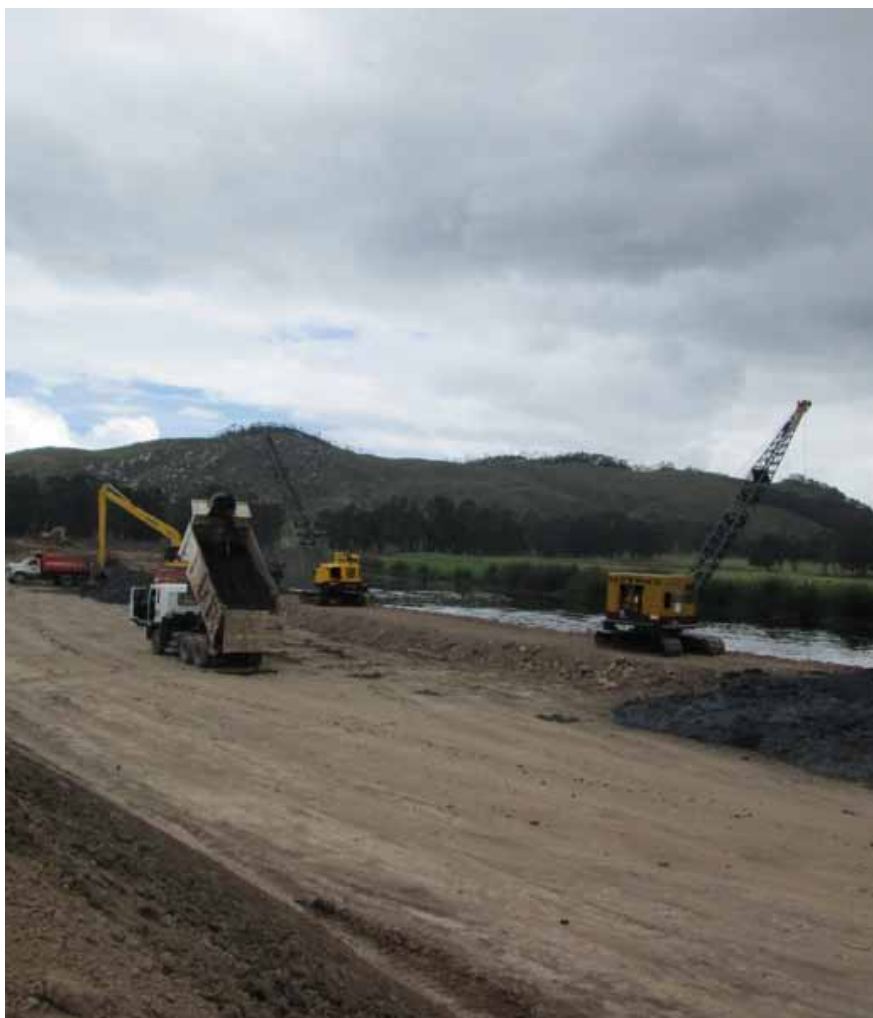
Ampliación del cauce del río
