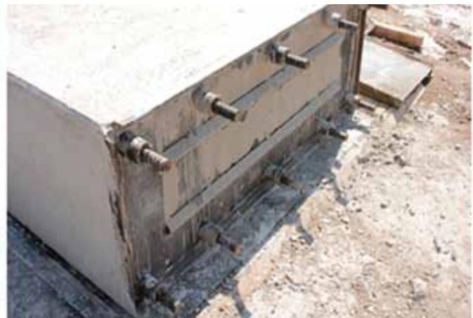
Fig. 5. Zona de conexión entre pilares prefabricados
