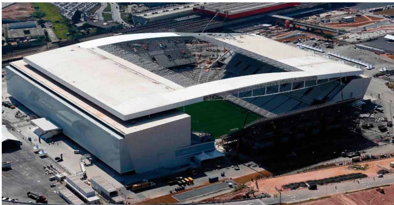
Fig. 1. Vista general del estadio
