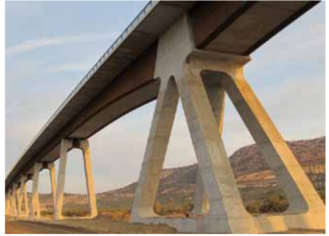
Viaducto de Archidona. Premio de Ingeniería ACHE 2014 en la categoría de Obra Civil
