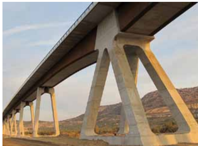
Viaducto de Archidona. Premio de Ingeniería ACHE 2014 en la categoría de Obra Civil
