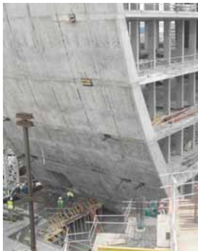
Cajetines para tesado longitudinal en plantas 1ª a 4ª y operación de tesado de la planta 1ª
