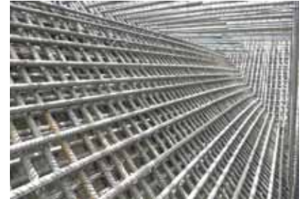
Losa de cimentación
