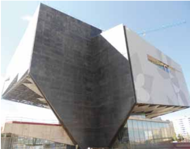
Edificio Caixa Forum, Zaragoza. Premio de Ingeniería de ACHE 2014
