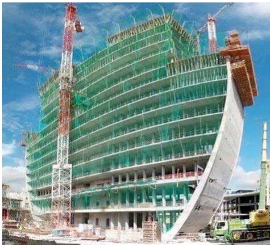
Muros testers de espesor variable, pilares de fachada y núcleo rígido en una etapa intermedia
