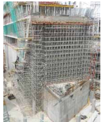
Cajetines para tesado longitudinal en plantas 1ª a 4ª y operación de tesado de la planta 1ª
