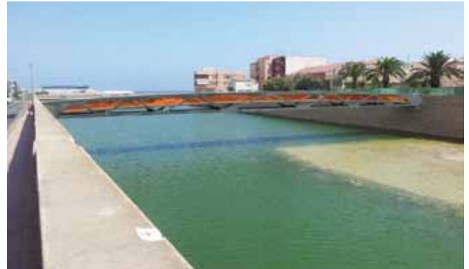
Pasarela Barranco de la Ovejas (Alicante), galardonada con uno de los II Premios de Ingeniería ACHE
