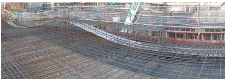
Viga upstand postesada en cubierta
