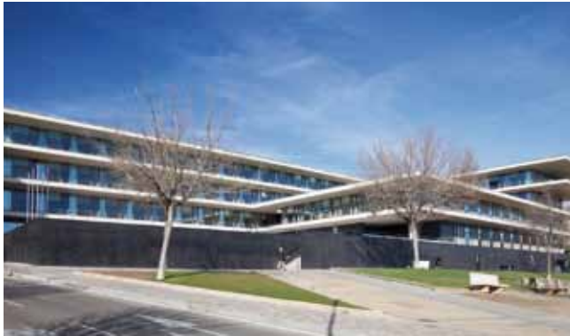
Edificio Administrativo en Salamanca. Premio de Ingeniería de ACHE 2014 en la categoría de Edificación
