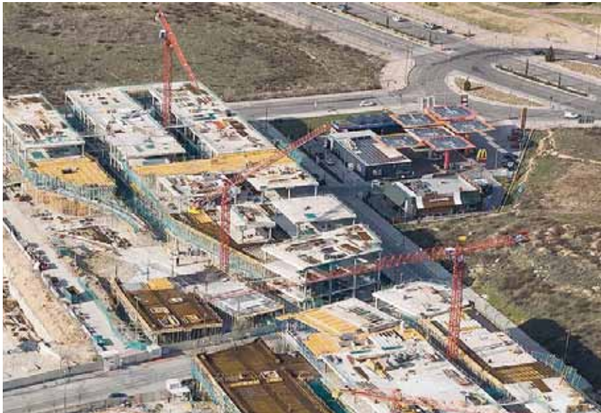
Fase I: los dos edificios preexistentes en proceso de transformación geométrica
