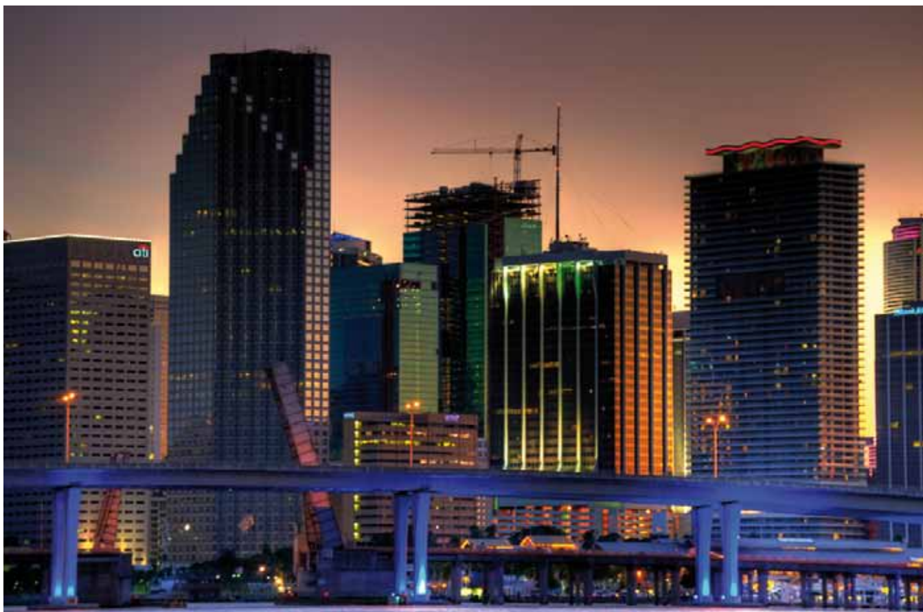
Puente Port of Miami (Typsa)
