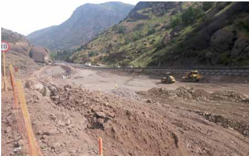
Terraplén sobre el estero Los Loros (FCC)
