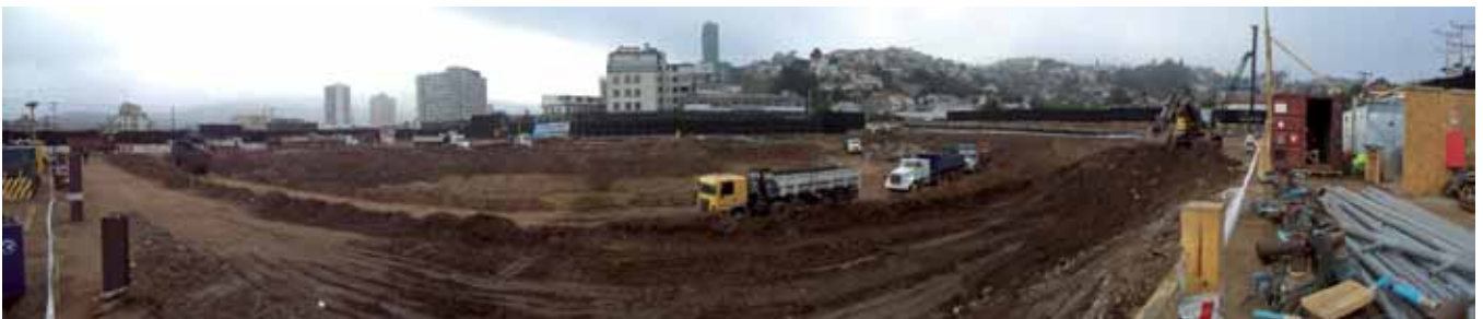
Obras del hospital Gustavo Fricke (OHL)
