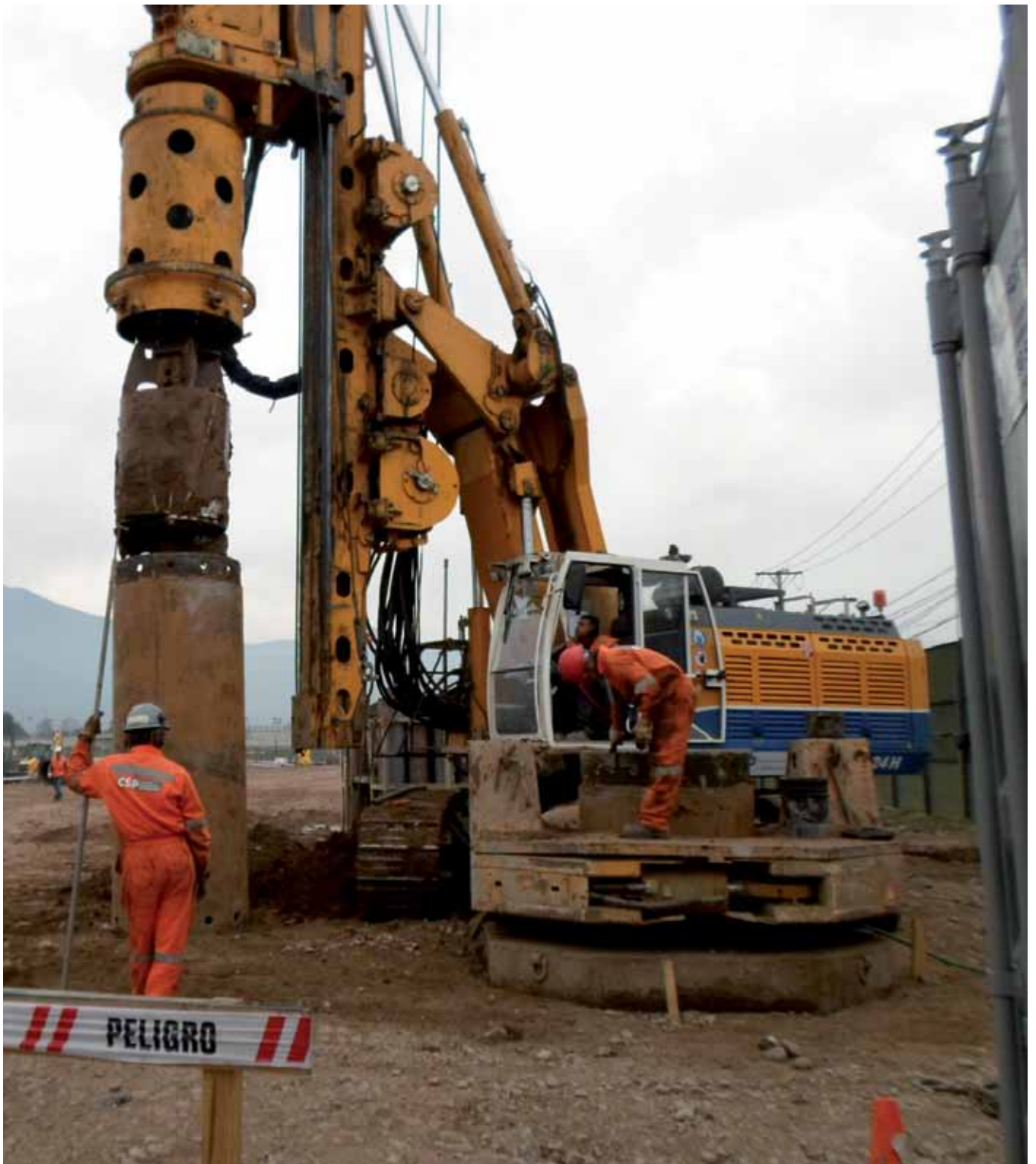
Excavación para el metro de Santiago (OHL)
