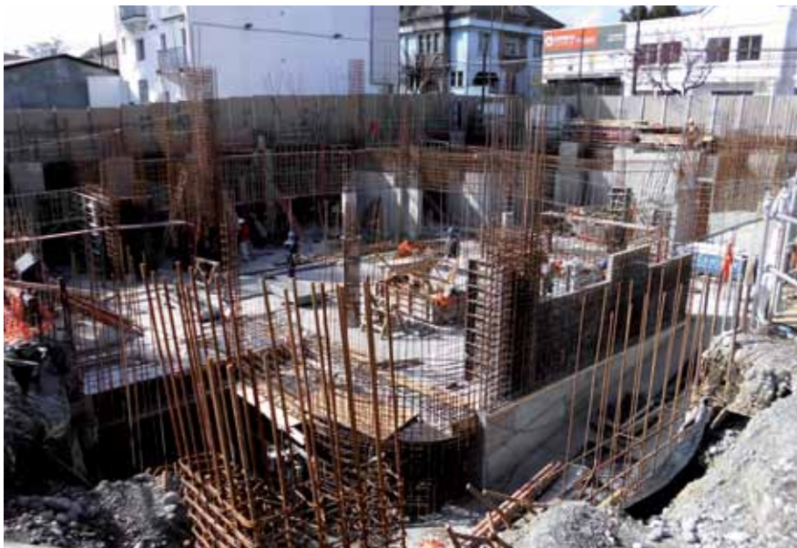
Construcción del edificio consistorial de Osorno (Ecisa)
