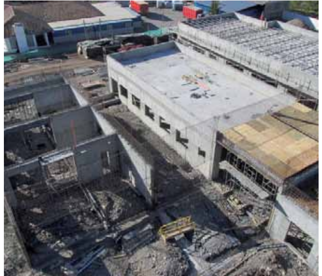
Construcción del hospital de Salamanca (Grupo Ortiz)
