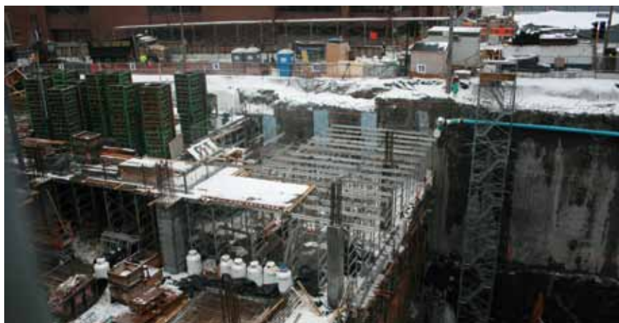
Obras en la zona B del Hospital de Montreal (CHUM)
