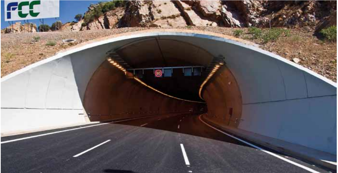
Túnel Despeñaperros, boca sur
