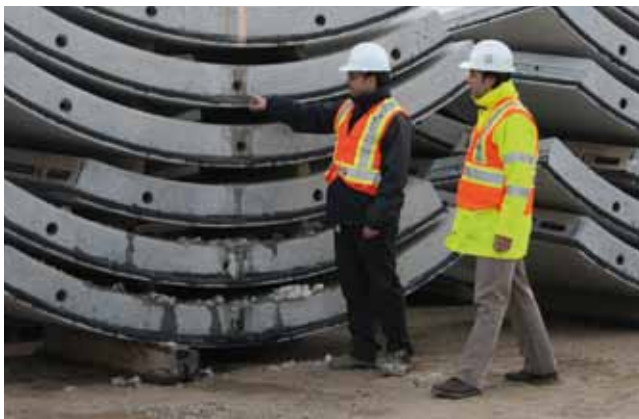
José Luis Cruz y Guillermo Montes, projects managers de FCC, revisando las dovelas de la obra del metro de Toronto
