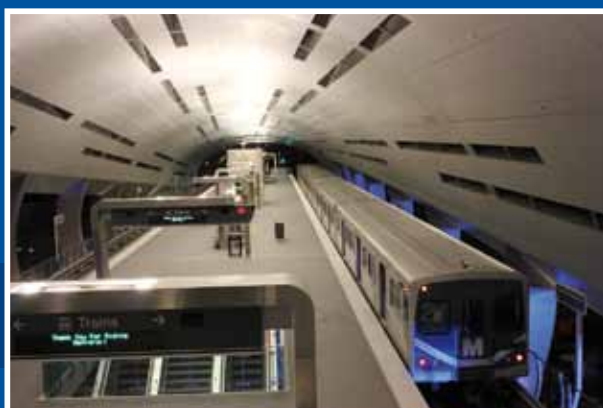
Metrorail Orange Line. Miami. USA.
