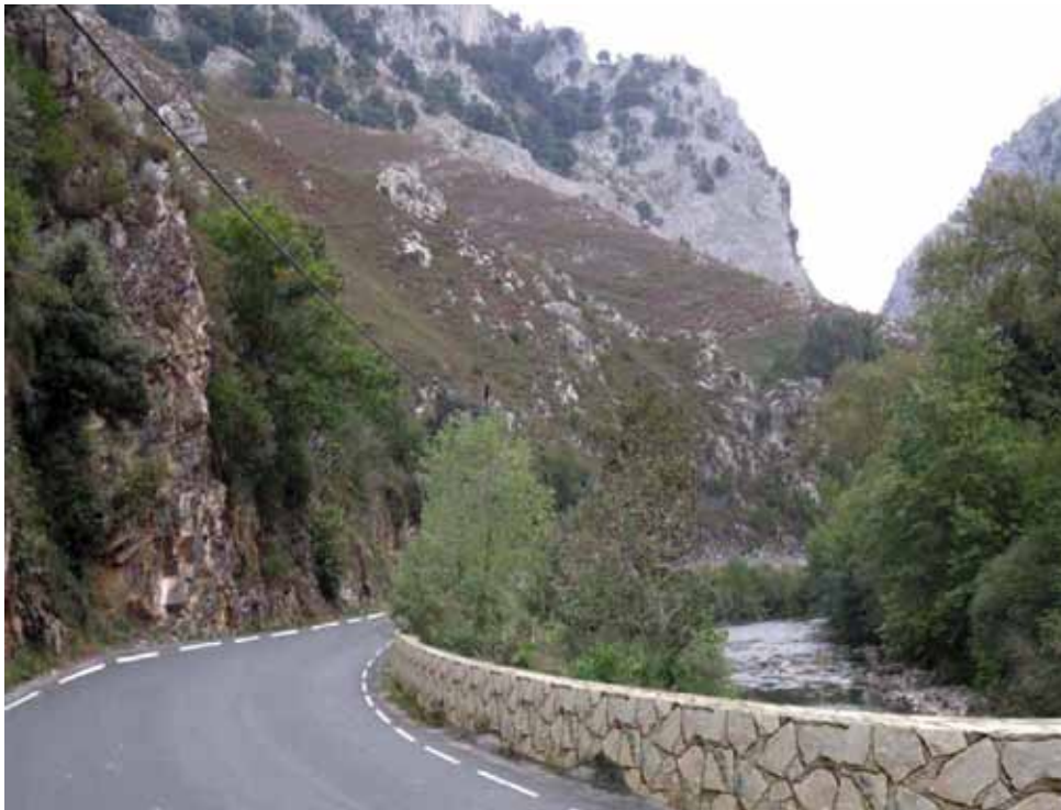
Fig. 4. Barrera de mampostería con gateras para evitar el encajonamiento y el riesgo de atropellos
