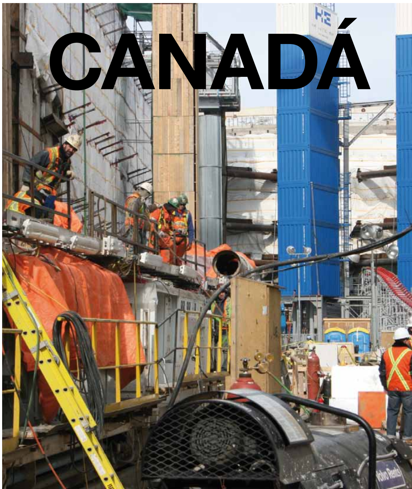
Obras de ampliación del metro de Toronto
