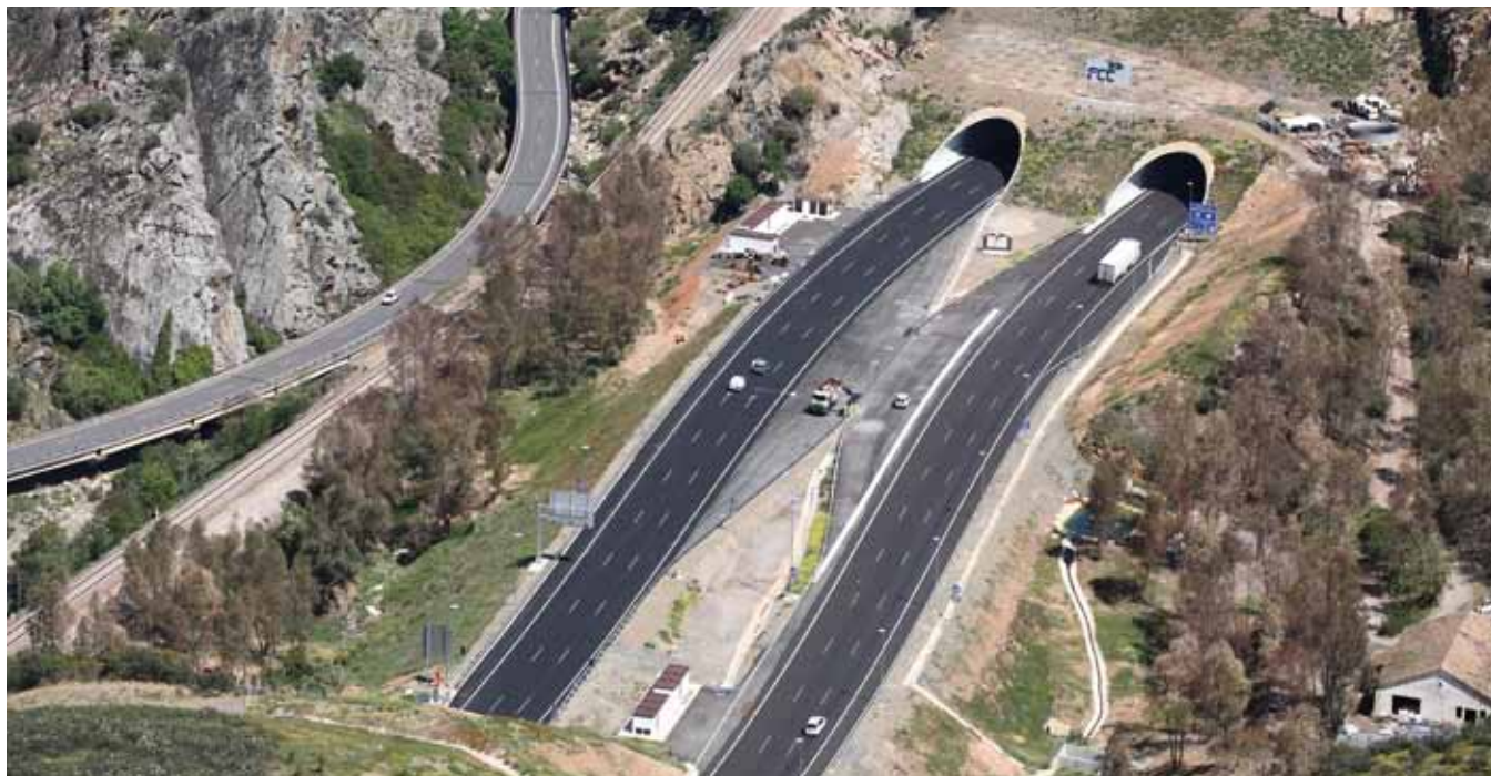
Vista aérea de la entrada al nuevo túnel de Despeñaperros
