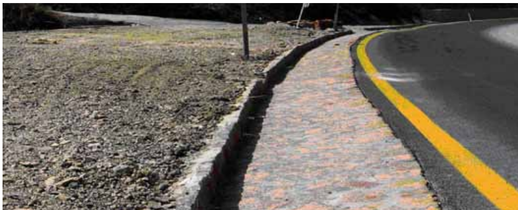
Fig. 6. Cuneta revestida de piedra junto a tramo abandonado y acondicionado para revegetación
