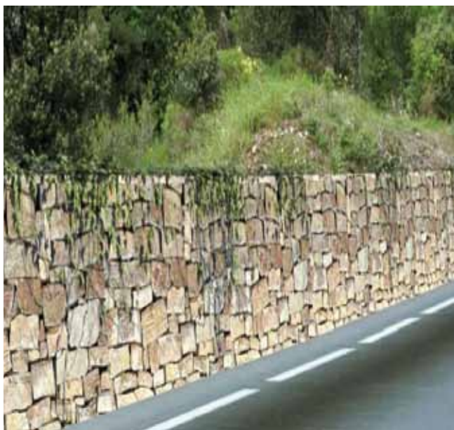
Fig. 7. Muros encachados a pie de desmonte para integración paisajística
