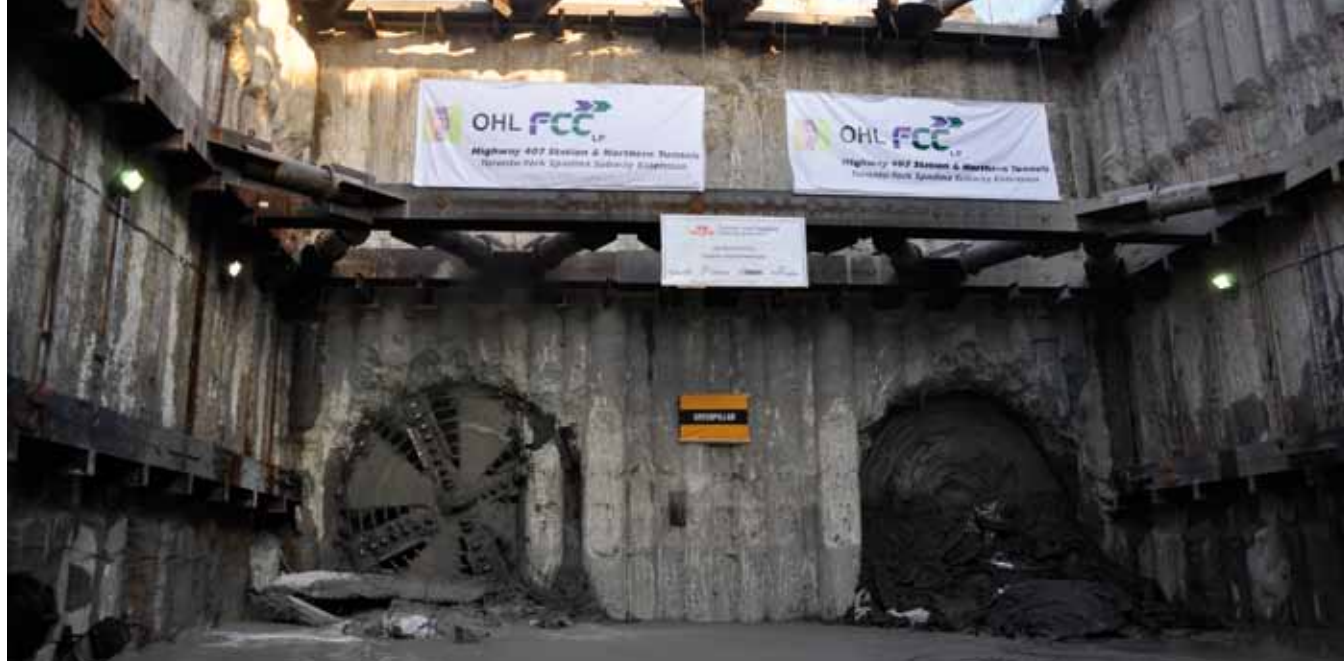
Salida de las tuneladoras después de hacer el primer tramo de túnel de la ampliación del metro de Toronto
