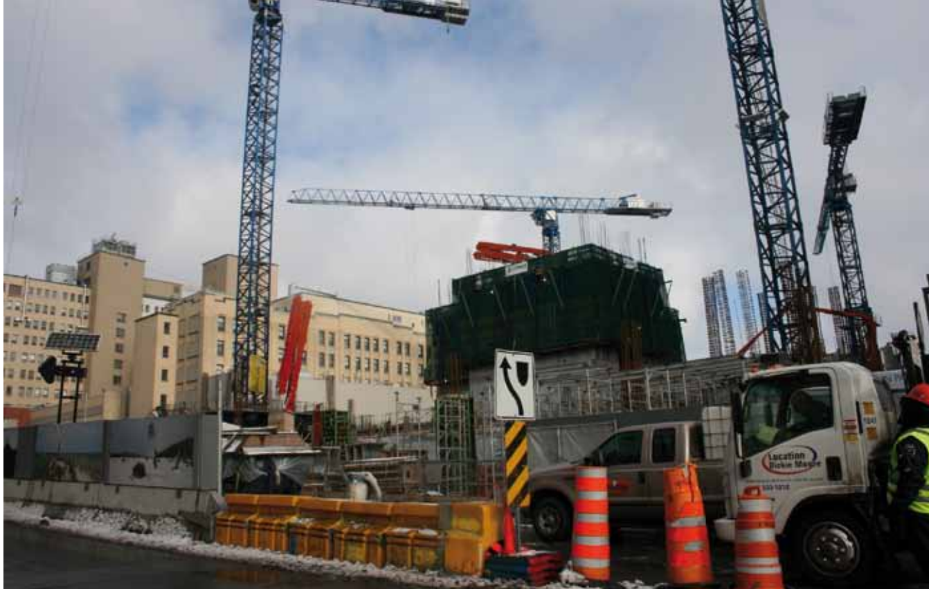
Trabajos de construcción del complejo sanitario de Montreal junto al actual Hospital St-Luc que será demolido en la II Fase
