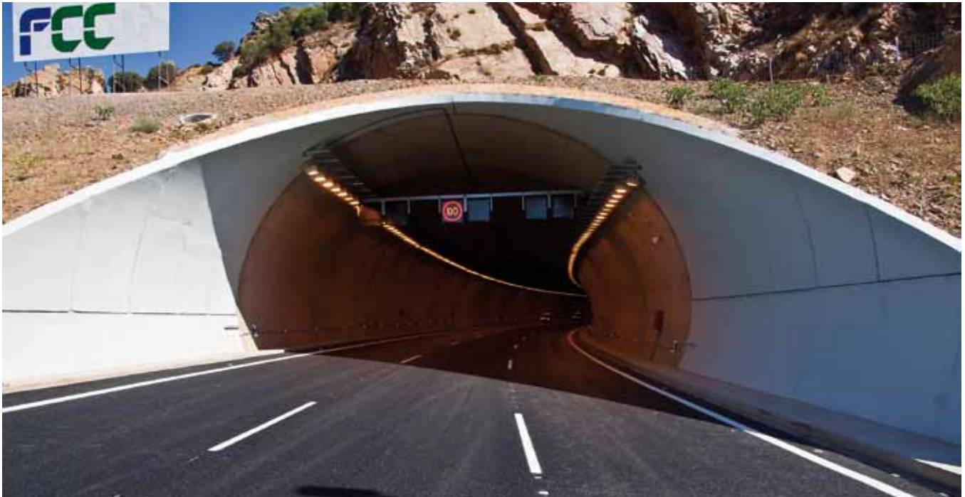
Túnel Despeñaperros, boca sur
