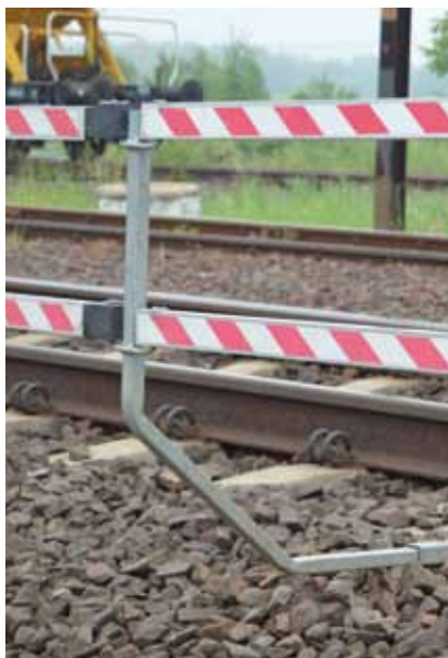
Modernas pantallas de seguridad que impiden que los trabajadores accedan a la vía en funcionamiento en la remodelación de la estación de Szelligi
