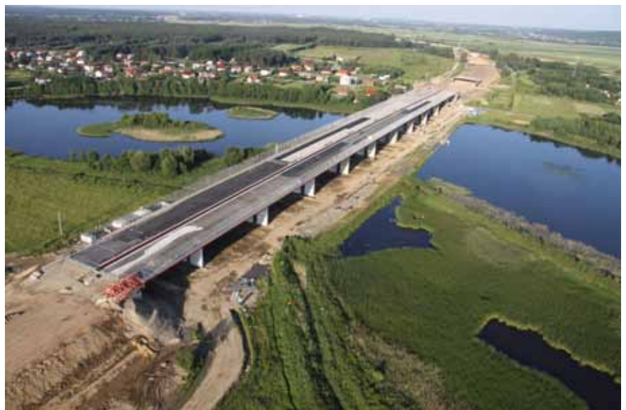
Autopista A4 de Tarnów a Dębica (Cracovia), obra realizada por Budimex
