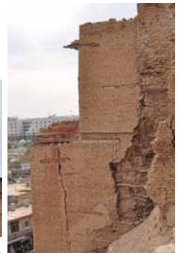
Fig. 6. Análisis de la estabilidad del talud y fotografía del estado del edificio (INES, 2012)
