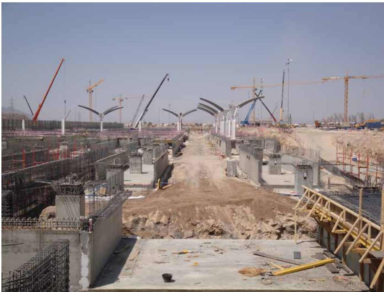
Obras del AVE (Consortio Español de Alta Velocidad Meca-Medina)
