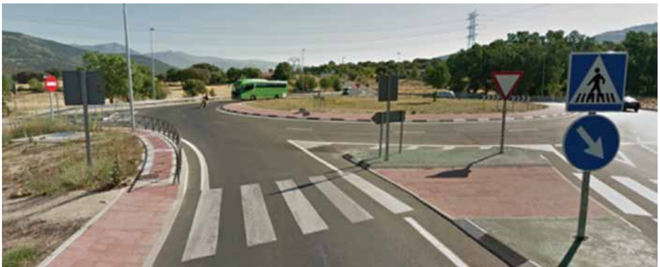
M-608. Remodelación del acceso y salida norte mediante una glorieta en Collado Villalba (Madrid)
