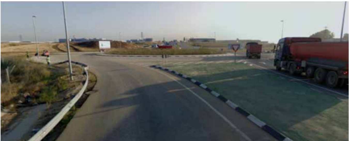
M-419. Glorieta de conexión entre la nueva carretera M-419 y la avda. de La Cantueña
