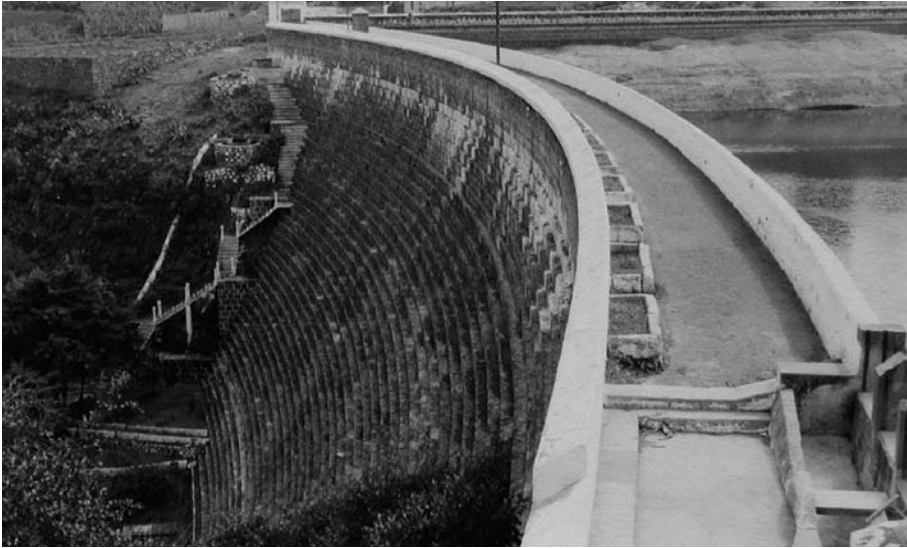
Fig. 1. La represa del Pinto (VP)/The Pinto dam (P).
