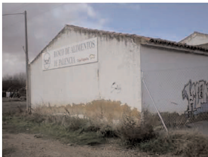
Fig. 2. Evidencias geomorfológicas (sedimentos fluviales/revocado en fachada).
