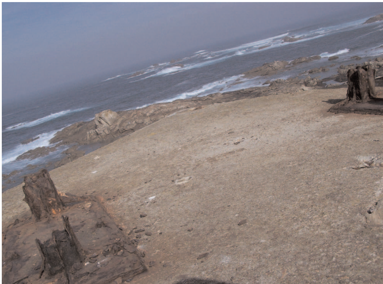
Fig. 14. Base de la torre del faro viejo de cabo Silleiro, en donde estaba instalada antiguamente la linterna cuya óptica fue desmontada para instalar en su lugar la bocina de la sirena de niebla, la cual iba anclada por estos hierro a una placa de hormigón.
