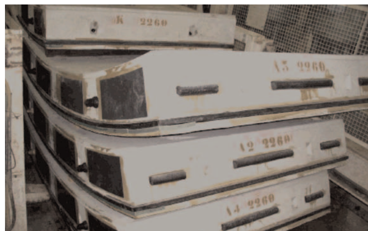
Fig. 12. Dovelas con juntas hidrofílicas.
