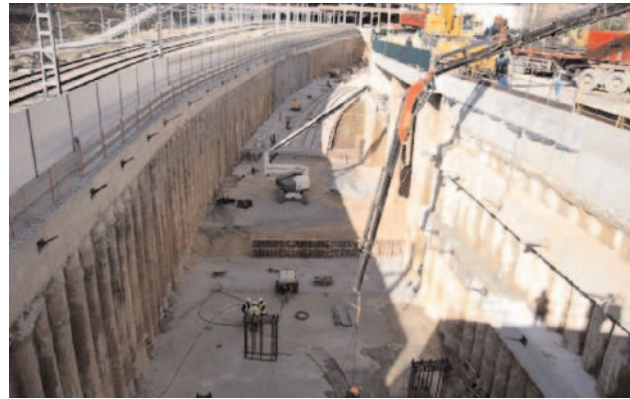
Fig.3. Ejecución pozo ataque enero 2010.
