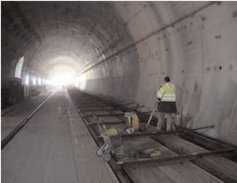
Fig. 28. Operación de vertido del elastómero. A la derecha, Fig. 29. Control topográfico.
