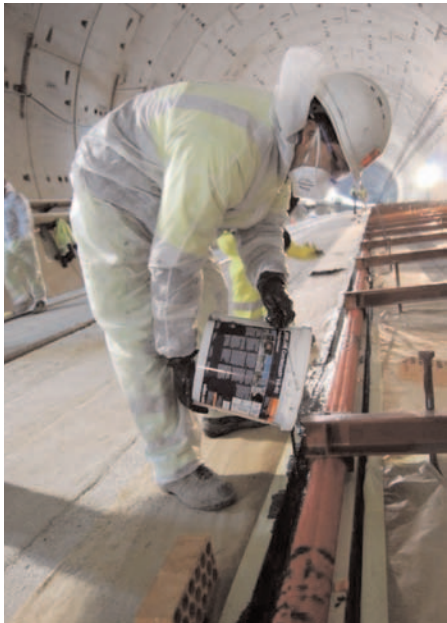
Fig. 28. Operación de vertido del elastómero. A la derecha, Fig. 29. Control topográfico.
