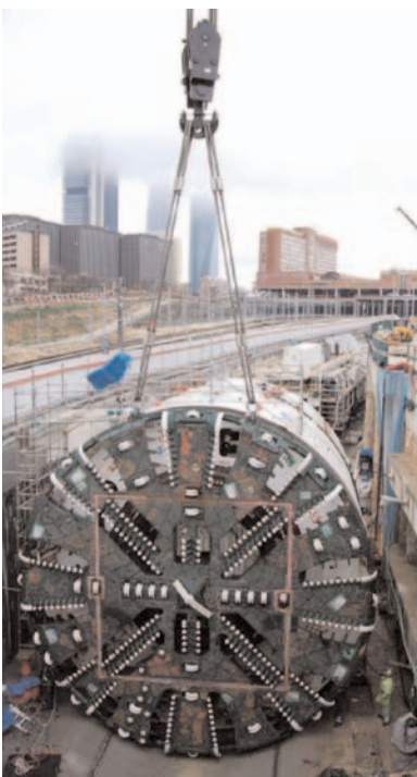
Fig. 2. Montaje rueda de corte marzo 2010 en Chamartín y desmontaje en Atocha en febrero de 2011.
