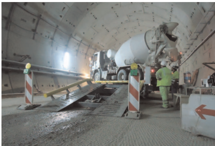
Fig. 25. Plataforma para el giro de los camiones dentro del túnel. A la derecha, Fig. 26. Operación de comprobación topográfica de canaleta.
