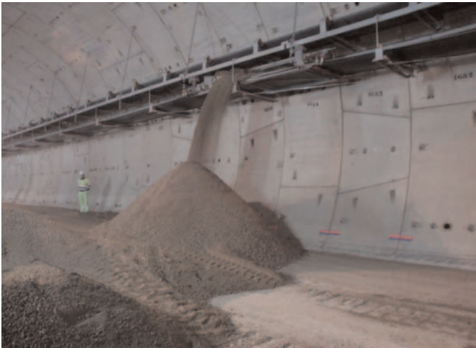
Fig.21. Vertido del hormigón del relleno mediante la cinta transportadora de extracción del material de excavación. A la derecha, Fig.22. Compactación del relleno.
