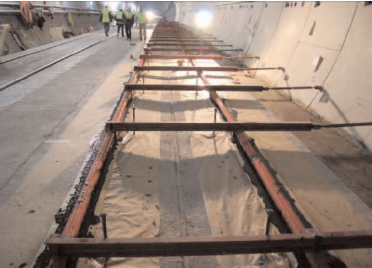
Fig. 27. Carril nivelado mediante las falsas traviesas y vertido el elastómero.
