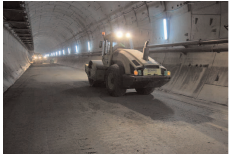
Fig.21. Vertido del hormigón del relleno mediante la cinta transportadora de extracción del material de excavación. A la derecha, Fig.22. Compactación del relleno.
