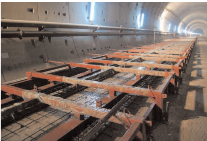
Fig.23. Moldes y armadura para el vertido del hormigón de la losa. A la derecha, Fig.24: Vertido de hormigón en los moldes.
