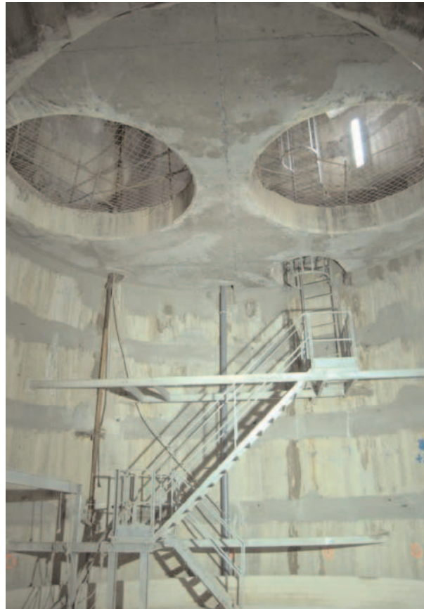
Fig. 31. Pozo ventilación y losa para la instalación de 2 ventiladores axiales.
