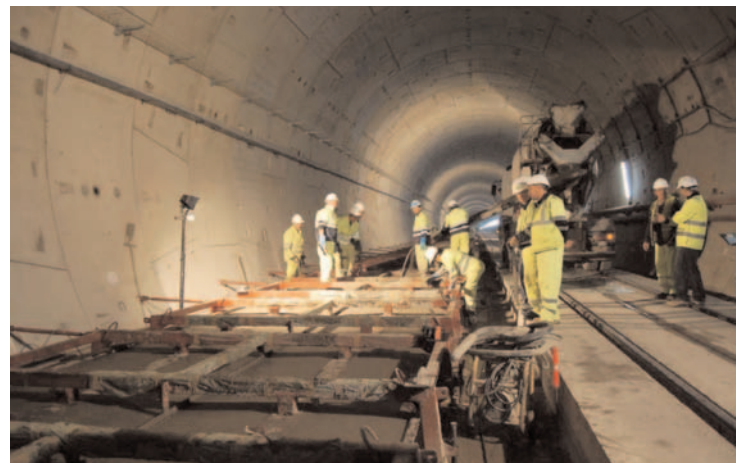
Fig.23. Moldes y armadura para el vertido del hormigón de la losa. A la derecha, Fig.24: Vertido de hormigón en los moldes.
