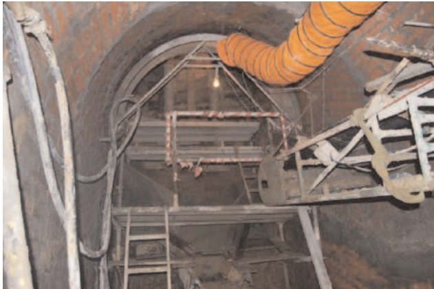
Fig. 16. Excavación de la galería para la salida de emergencia a uno de los aparcamientos de Serrano.
