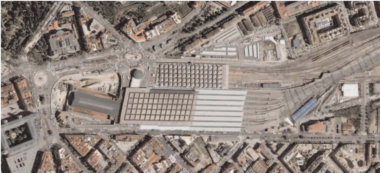
Fig. 2. Vista aérea de Atocha antes de la última reforma.
