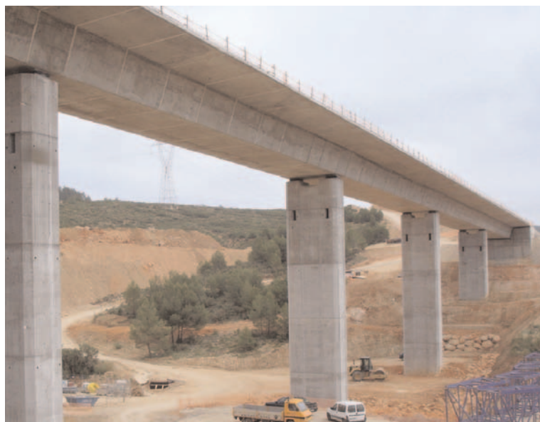
Fig. 1. Vista durante la construcción.
