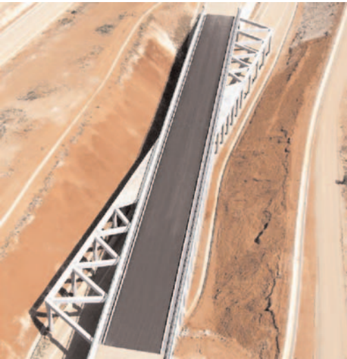
Fig.1. Pérgola en la L.A.V. Madrid-Levante en Motilla del Palancar; a) Vista general antes de la colocación de la plataforma; b) Sección transversal.
