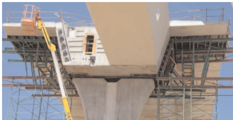
Fig. 4. Zona de unión entre el tramo "in situ" y el tramo prefabricado.
