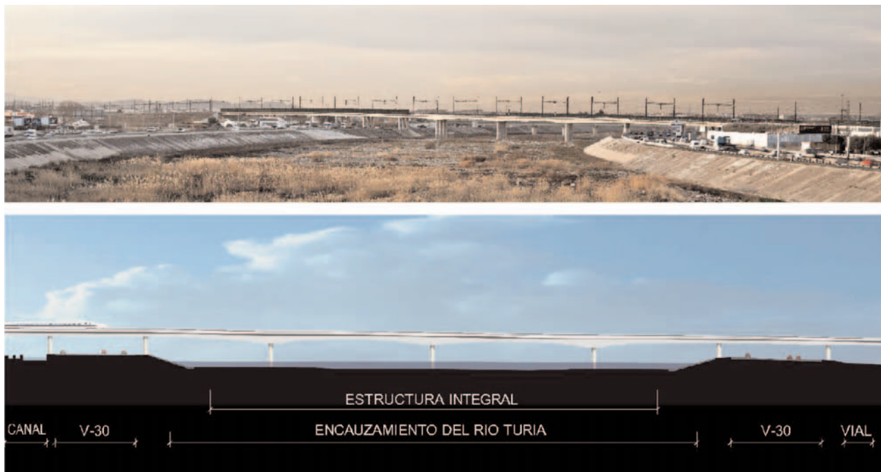
Figs. 2 y 3. Fotografía y alzado del Viaducto del Turia en la zona sobre cauce.
