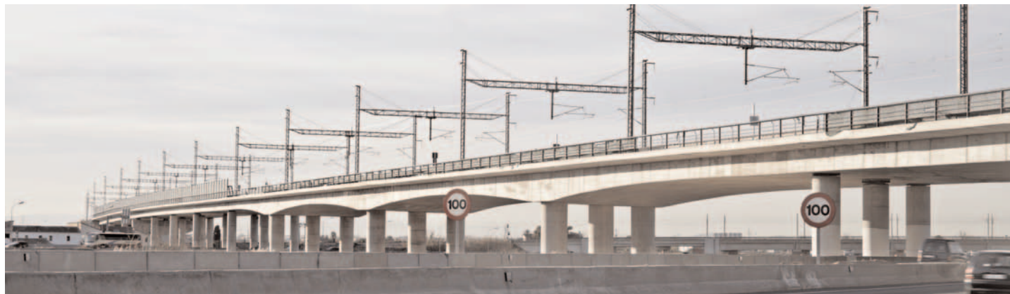
Fig. 1. Vista del Viaducto del Turia desde la carretera V-30.
