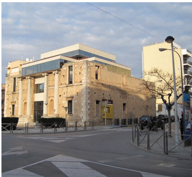
Fig. 3. Restos de la Iglesia Nueva de San Carlos de la Rápita alrededor de la cual se establecería la población de San Carlos abandonando las construcciones de las fotos anteriores. No se concluyó y actualmente se aprovecha como local para actividades diversas.
