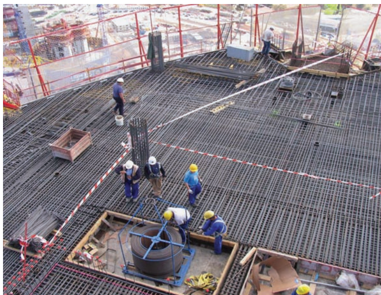
Fig. 17. Ferrallado planta.
