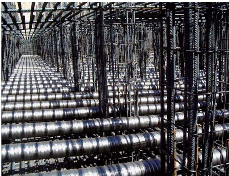
Fig. 11. Vainas de pretensado en losa de cimentación.
