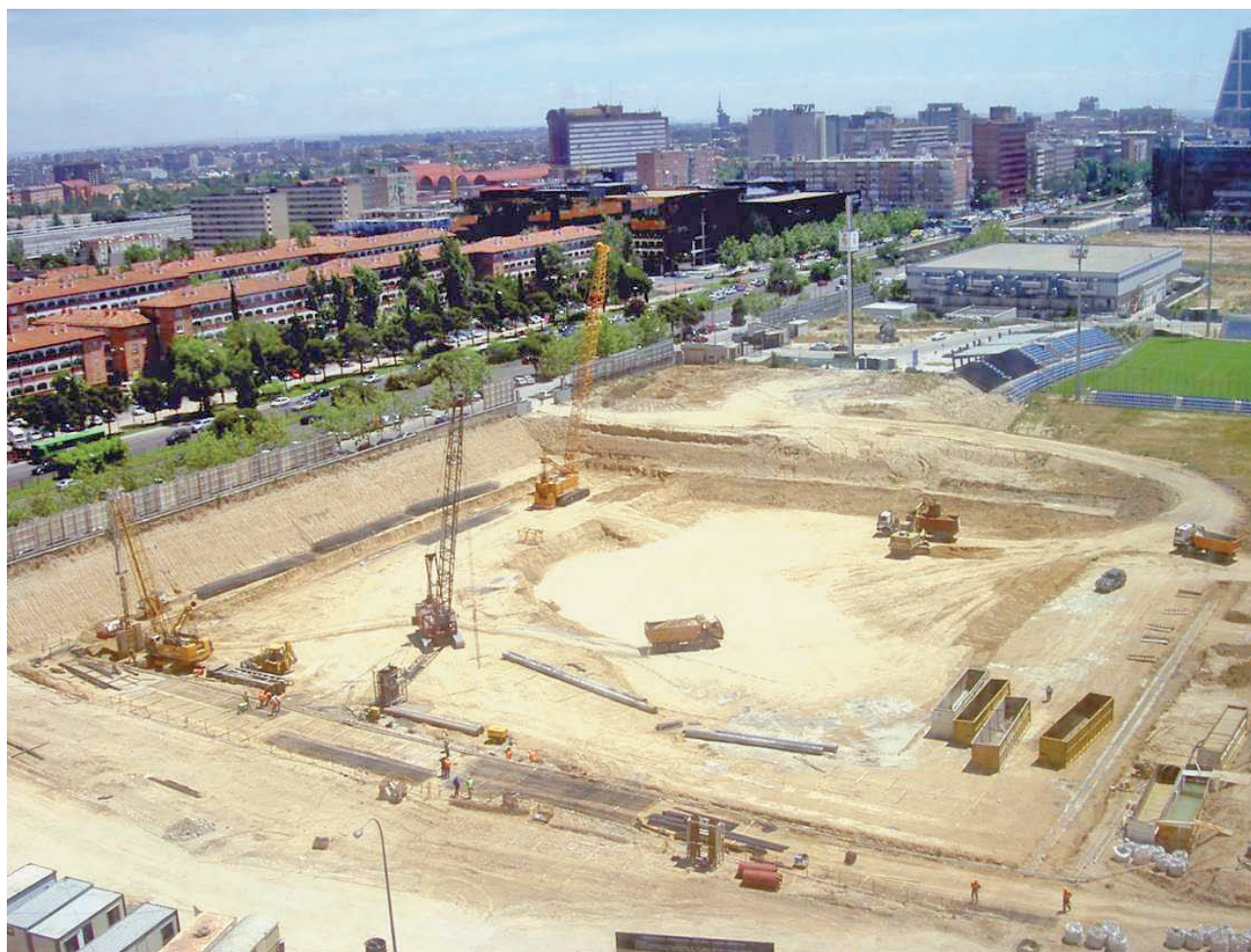
Fig. 4. Excavación del solar.
