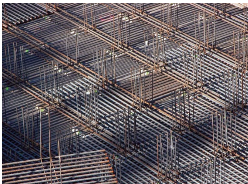
Fig. 12. Industrialización ferralla de losa de cimentación.
