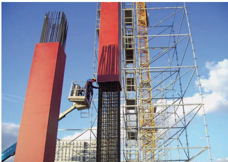
Fig. 8. Pilar exento de fachada.
