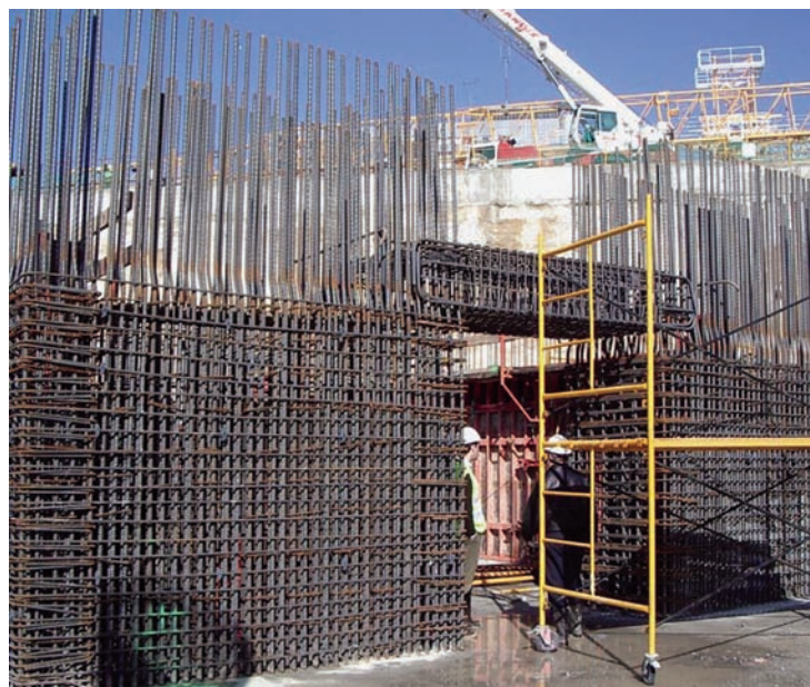
Izquierda, fig. 15. Cercos en nudos de estructura. A la derecha, fig. 16. Montaje ferralla de núcleo.
