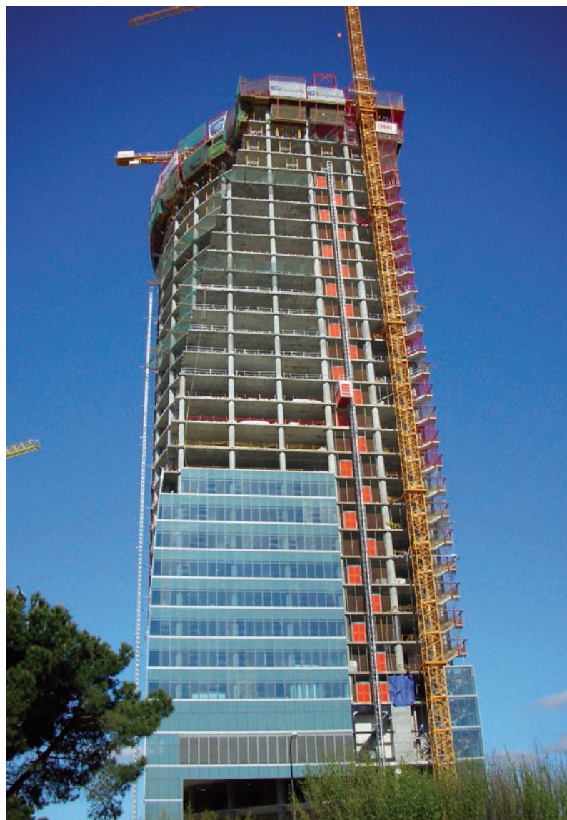
Fig. 23. Fachada de Torre Espacio.
