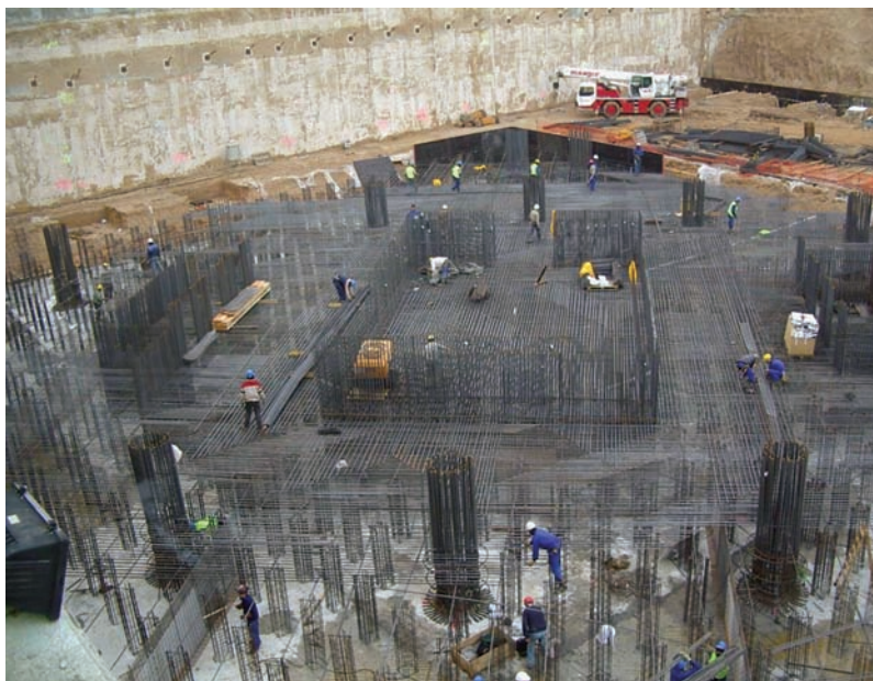
Fig. 10. Armadura de espera en losa de cimentación.
