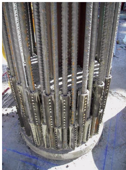
Izquierda, fig. 13. Montaje ferralla de soportes. A la derecha, fig. 14. Empalmes de armadura con manguitos.
