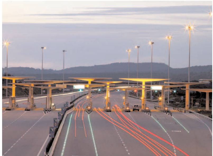
La no existencia de barreras en peajes facilita los tránsitos en horas punta, manteniendo la privacidad del usuario.
