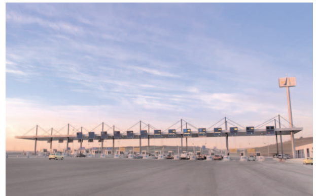
Sistema "Free Flow" o multicarril necesario en tecnología basada en sistemas de microondas DSRC.
