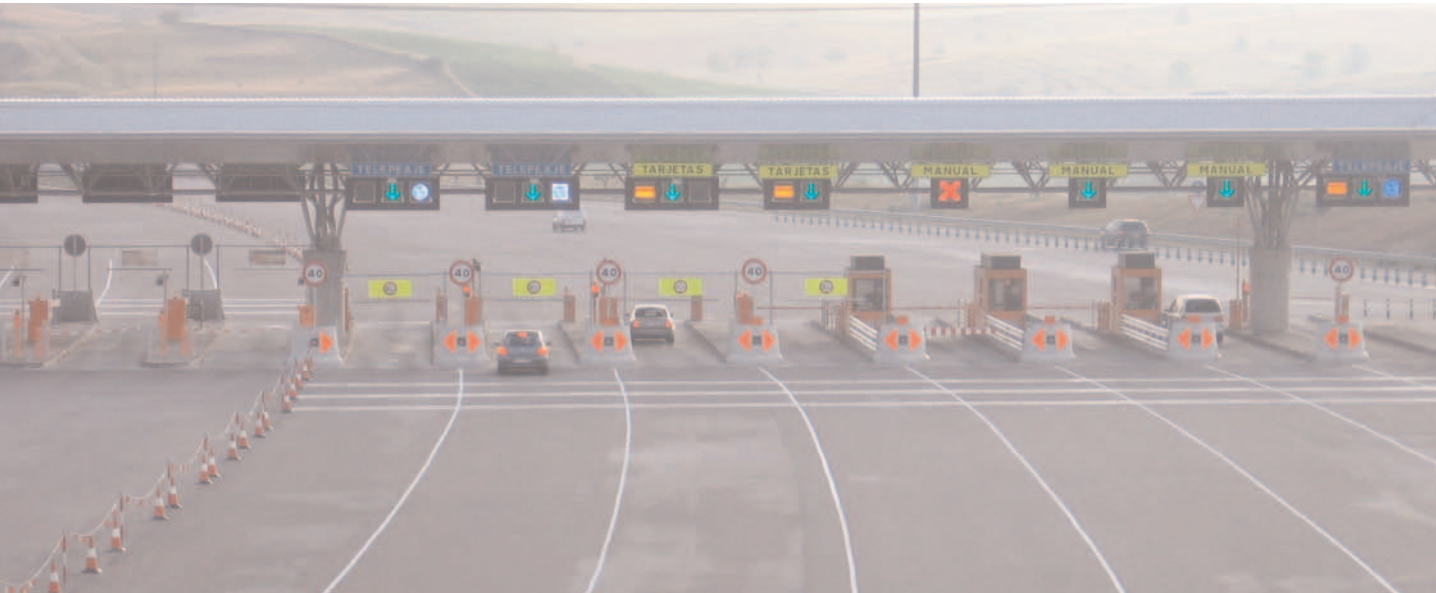
Playa de peaje en la autopista R-5 con carril de telepeaje implantado en España con tecnología DSRC.
