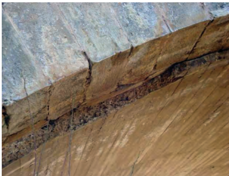
Fig.10. Contacto de una bóveda de hormigón del puente de Lavalé y los aristones de sillaría (Fotografía: Juan Donaire Merino).
