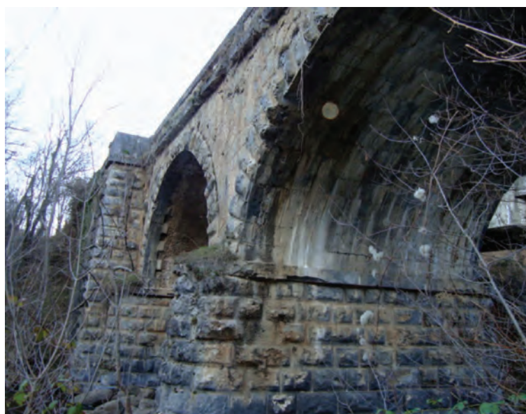
Fig. 12. Vista del puente de Lumbreras (Fotografía: Juan Donaire Merino).
