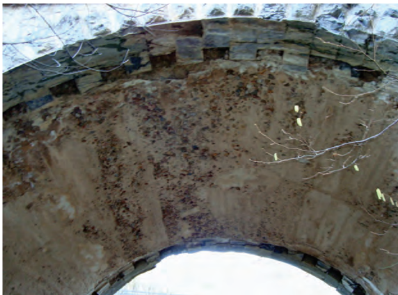
Fig.9. Puente de Lumbresas. Se aprecian las llaves de trabazón entre los aristones de sillaría y la bóveda de hormigón (Fotografía: Juan Donaire Merino).
