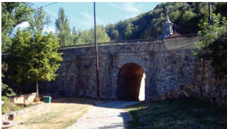
Fig. 6. Alcantarilla de Villanueva de Cameros. (Fotografía: Juan Donaire Merino).
