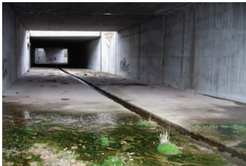
Fig. 1. Paso de fauna Arroyo Vitoras, autopista AP-61, Fuente: Iberpistas S.A./ Arroyo Vitoras fauna passage, AP-61 motorway. Source: Iberpistas S.A.
