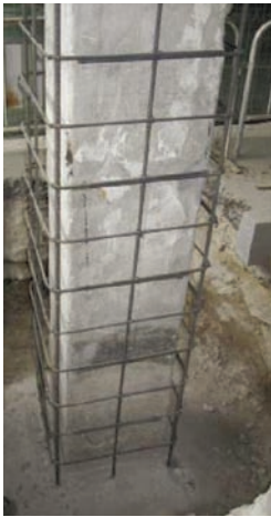
Detalle de refuerzo de pilas y encuentro con estribos.
