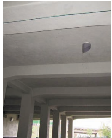
Detalles de drenaje en el tablero del puente.
