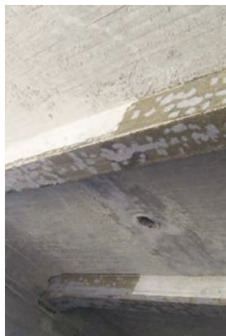
Detalle de vigas preparadas para refuerzo con fibra de carbono.
