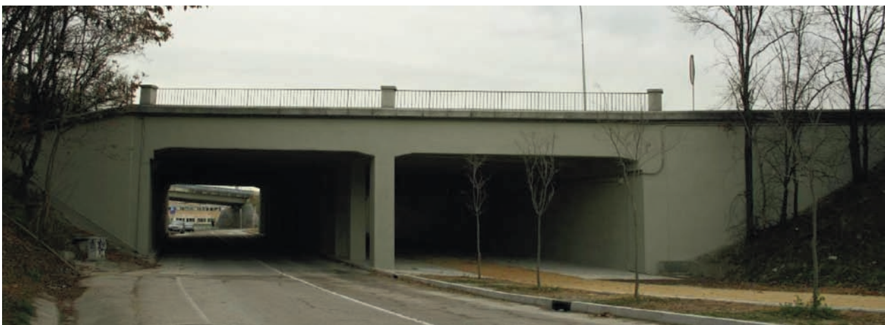
Vista del alzado del puente una vez concluida la rehabilitación.
