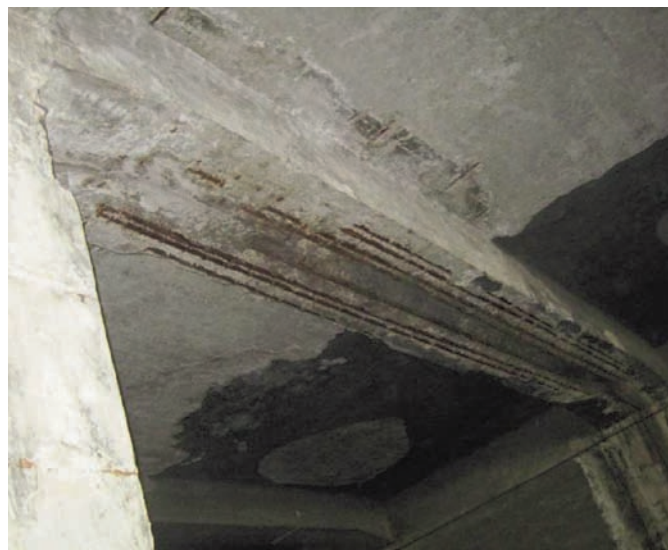
Detalle de las vigas centrales en la zona de la junta de la estructura
