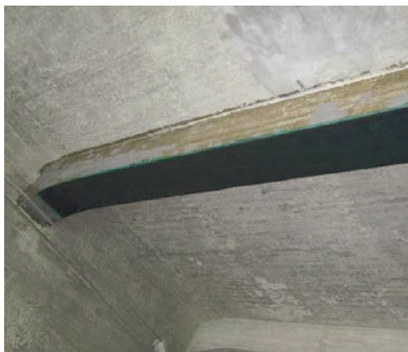
Detalle de refuerzo a flexión colocado.
