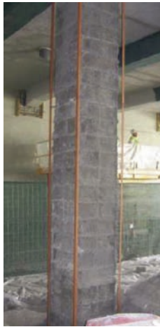
Detalle de refuerzo de pilas y encuentro con estribos.
