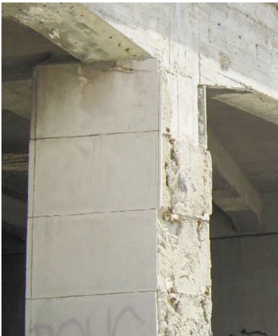
Detalle de pila con el aplacado.
