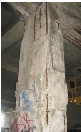
Detalle de pilas centrales.
