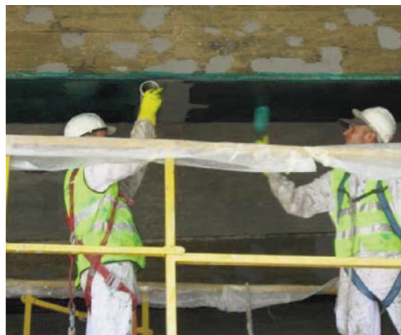
Detalle de aplicación de refuerzo a flexión.
