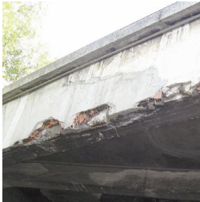
Detalle de aplacado en el alzado del puente.
