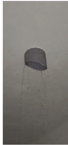
Detalles de drenaje en el tablero del puente.
