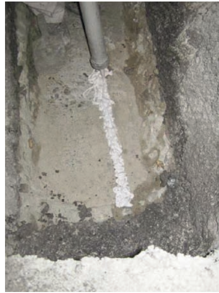
Detalles de ejecución de la impermeabilización de la junta central desde la A6.
