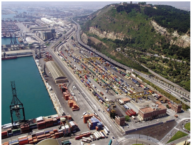
Terminal intermodal de Morrat (Barcelona).
