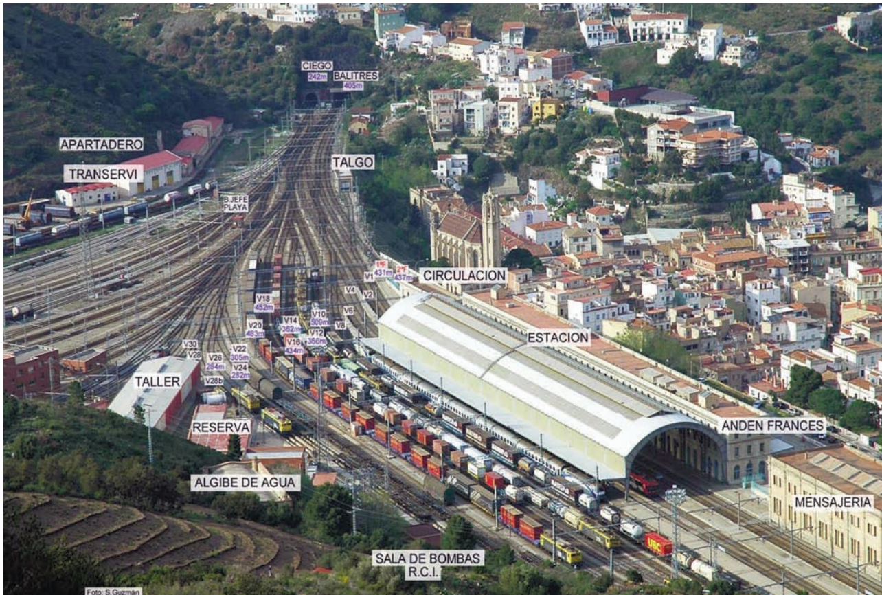
Estación de Port-Bou.
