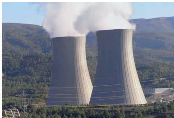
Central nuclear de Cofrentes (Valencia)/ Cofrentes nuclear power plant.
