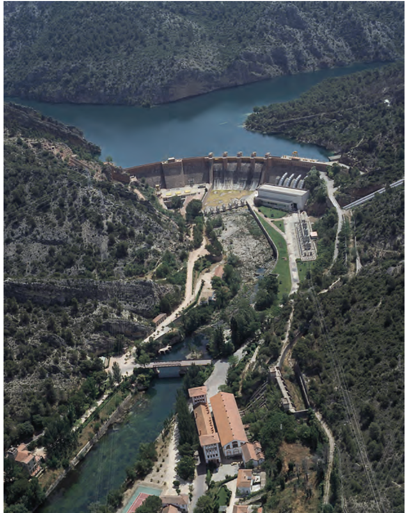
Central hidroeléctrica de Bolarque (Guadalajara)/ Bolarque hydroelectric power plant (Guadalajara).
