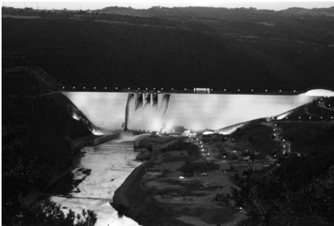
Presa de Hormigón Compactado con Rodillo (HCR) de Rialb. Confederación Hidrográfica del Ebro.
