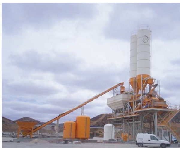
Fig. 5. Plantas de producción de "Hormigones y Minus": boca sur (izquierda) y boca norte (derecha).
