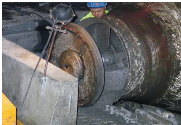
Fig. 4. Vertido de hormigón a las bombas.
