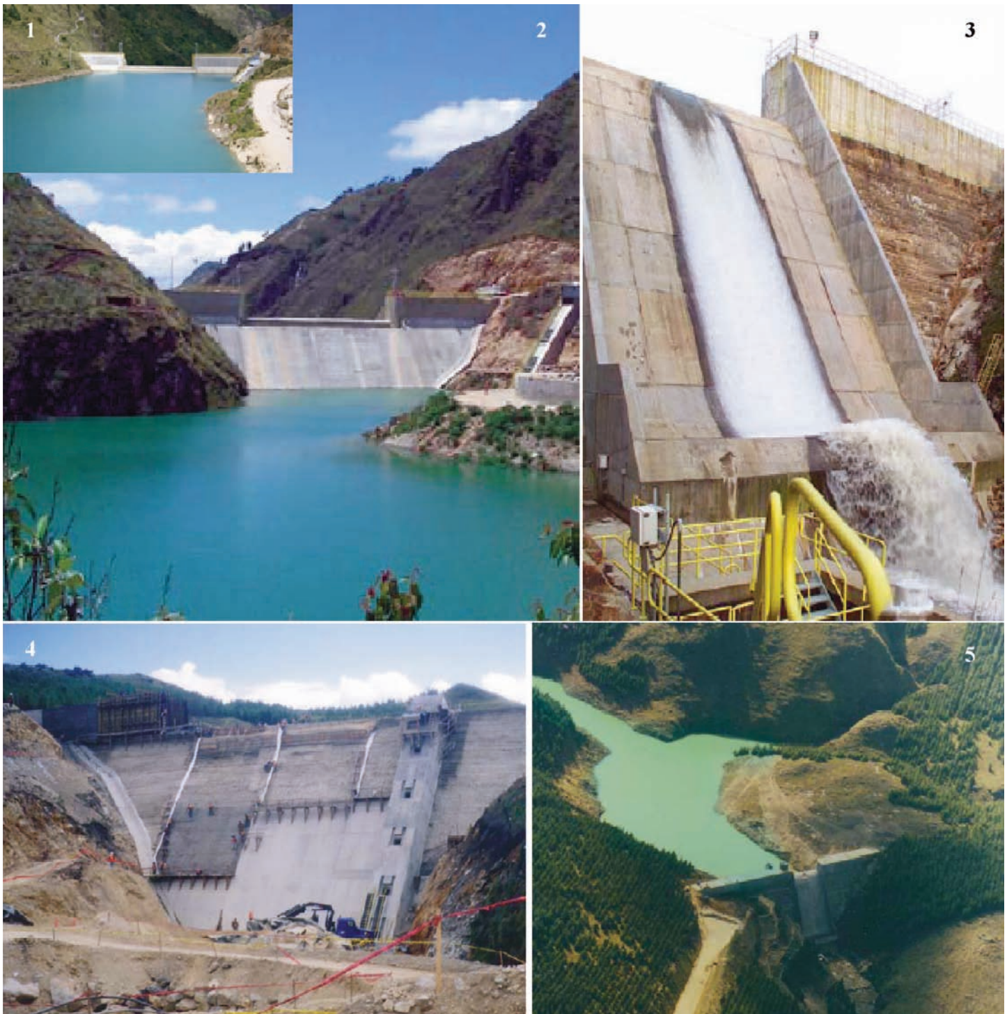
Fig. 28. Presas de concreto rolado compactado / Roller compacted concrete dams, RCCD. Sediment trapping dams / presas de control de sedimentos: [1,2] Presa Río Grande / Río Grande Dam (2004), h = 60 m; [3,4,5] Presa Río Rejo / Rejo River Dam (2003), h = 35 m. (Fotos fuente / Photos source: Minera Yanacocha, 2006).
