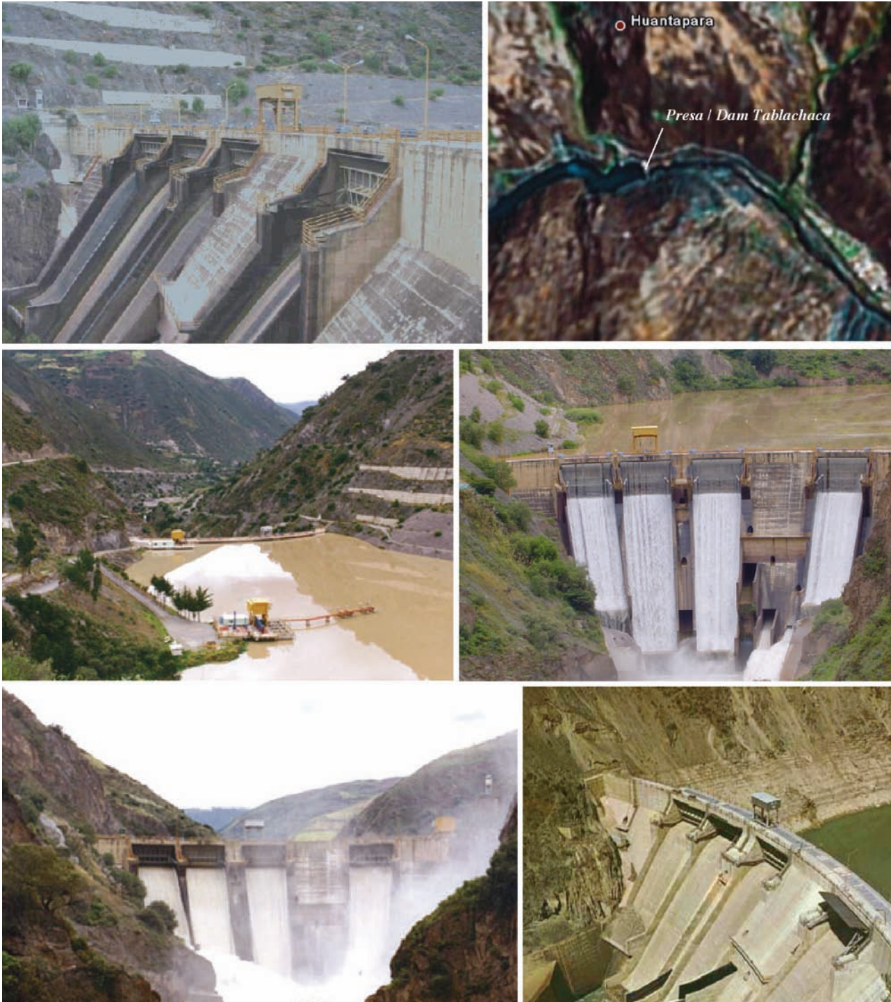
Fig. 7. Tablachaca (1973). Presa de arco de gravedad / Arch gravity dam, de 77 m de altura / of 77- m-high, 2697 m snm / m asl. (Fotos fuente / Photos source: Google Earth 2007, ELECTROPERU).
