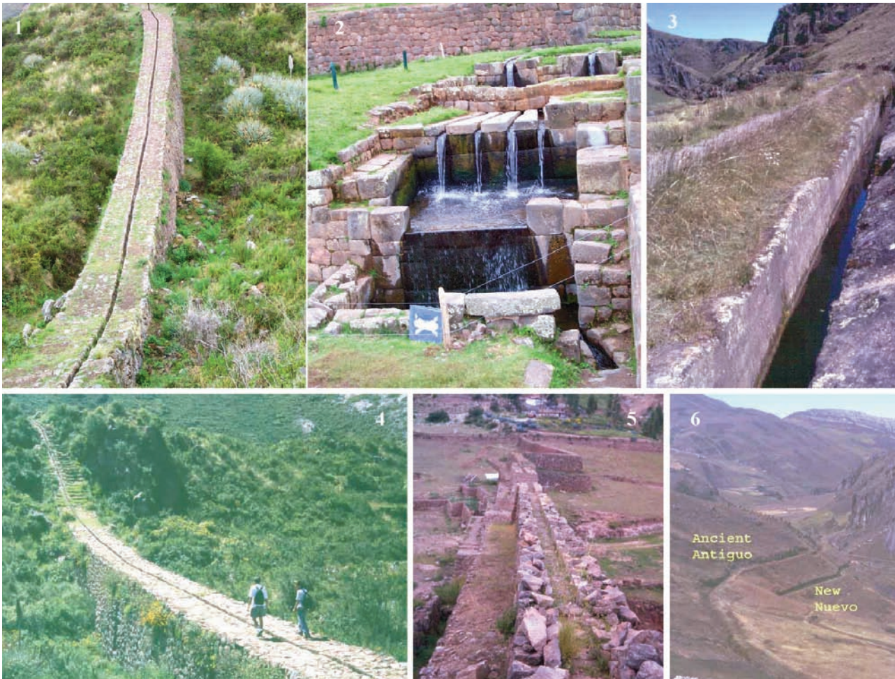
Fig. 1. Obras hidráulicas prehispánicas: [1,4] Acueducto de Tipun construido en mampostería, Cuzco; [2] Vertedero de Tipun hecho en mampostería Cuzco; [3,6] Acueducto de Cumbemayo excavado en roca Cajamarca; [5] Acueducto de Piquillakta / Prehispanic hydraulic structures: 1-4 Aque duct of Tipun, constructed of masonry, Cuzco; (2) weir of Tipun, made of masonry, Cuzco; (3,6) Aque duct of Cumbemayo excavated in rock, Cajamarca; (5) Aque duct of Piquillakta.
