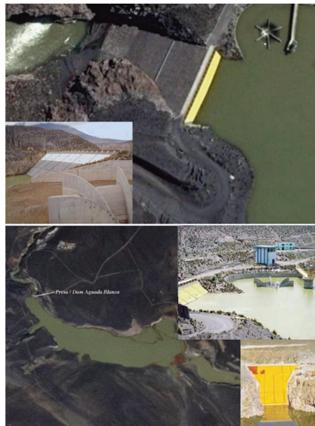
Fig. 5. Aguada Blanca. Presa de enrocado con pantalla de impermeabilización de acero / Steel face rockfill dam. (Fotos fuente / Photos source: Google Earth 2007, OSINERG, Electroconsult).
