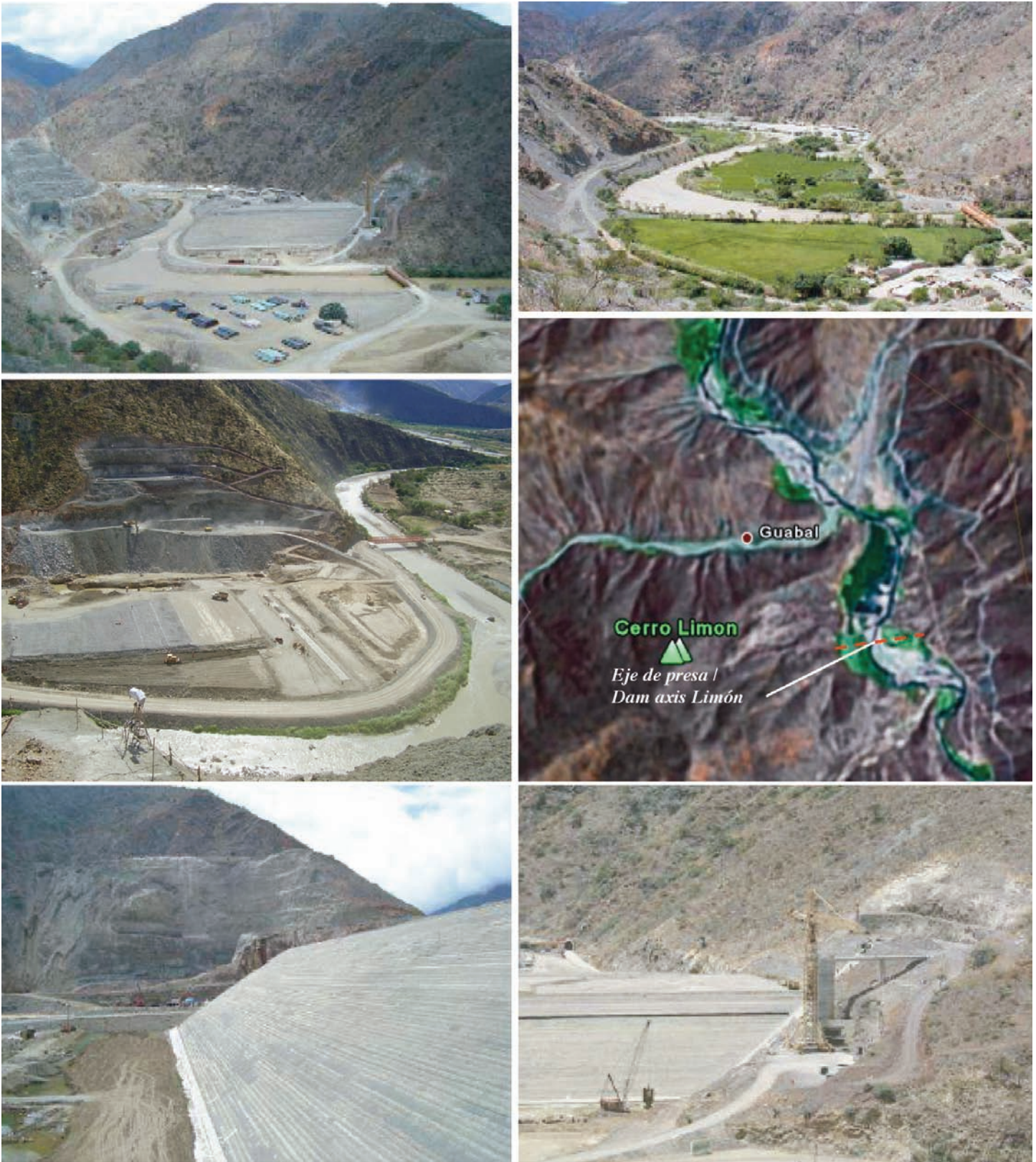
Fig. 26. Presa Limón, presa de enrocado con espaldón de concreto / concrete face rockfill dam - CFRD (h = 43 m), en construcción y se espera culminar su primera etapa en el 2008 / in construction and it is expected to be concluded its first phase in 2008. (Fotos fuente / Photos source: Google Earth 2007; DEPOLTI, ODEBRECHT).
