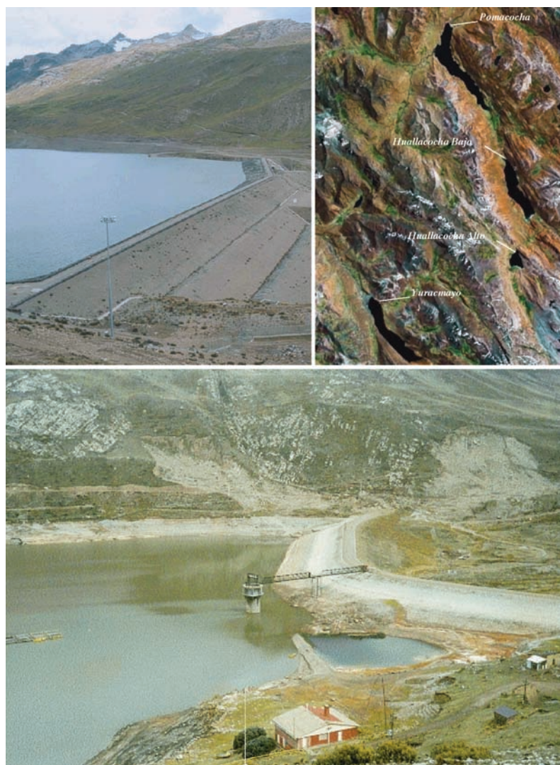
Fig. 3. Superior izquierda / Above left, presa / dam Yuracmayo. Abajo / Below, presa / dam Pomacocha, construida en 1914 y proyectada a ser sobre elevada a una altura total de 40 m como parte del proyecto de aprovechamiento de recursos hídricos Marca II para satisfacer la demanda de agua de la ciudad de Lima / constructed in 1914 and projected to be heightened for a total height of 40 m as part of the Marca II Water Resources Development Project in order to satisfy the water demand of Lima City. (Foto superior derecha / photo above right. Fuente / source: Google Earth 2007).
