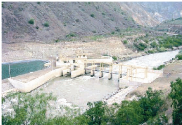
Fig. 18. Presas derivadoras con reservorio paralelo al río / Diversión dams with parallel reservoir to the river channel . Izquierda / Left , presa / dam San Diego. Derecha / Right , presa / dam San Gabán II. (Fotos fuente / Photos source : OSINERG, EGENOR, EGE San Gabán).
