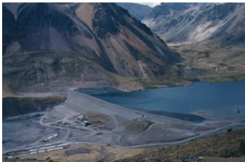
Fig. 25. Presa / Dam Antamina, 2002, presa de enrocado con espaldón de concreto / concrete face rockfill dam - CFRD. (Fotos fuente / Photos source: Minera Antamina, 2005).
