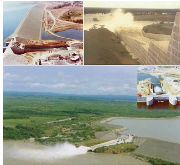
Fig. 4. Presa Poechos, concluida en / completed in 1976, permite una capacidad de almacenamiento de / allow an available storage volume of 885 x 10 6 m 3 . (Fotos fuente / Photos source: Energoprojekt, DEPECHP).
