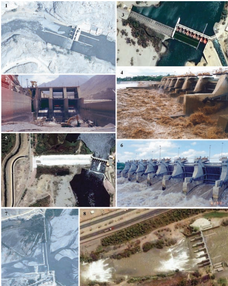
Fig. 19. Presas derivadoras / Diversión dam spillways . [1,2] Chavimochic, 1989; [3,4] Los Ejidos, 1985; [5,6] Sullana, 1997; [7] La Huaca, 1997; [8] Alfonso Alcedán La Cruz, 1968. (Fotos fuente / Photos source : [1,3,5,7,8] Google Earth 2007).
