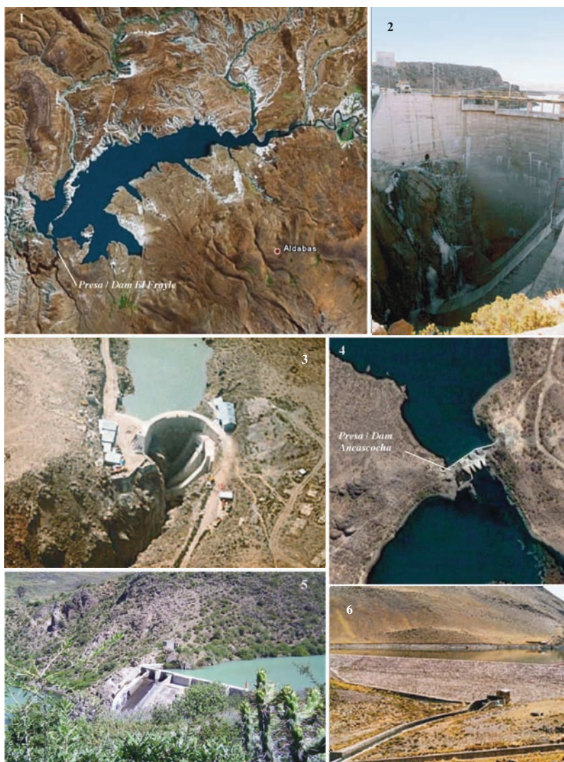
Fig. 14. Presas de gravedad / Gravity dams. [1,2,3] El Frayle, 1958, presa de arco / arch dam, 74 m de altura / 74-m-high, 4012 m snm / m asl; [4,5] Ancascocha, 1985, 40 m de altura / 40-m-high; [6] El Pañe, 1966, 13 m de altura / 13-m-high. (Fotos fuente / Photos source: Google Earth 2007, EGASA).
