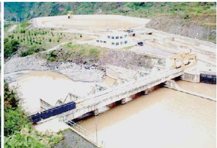
Fig. 18. Presas derivadoras con reservorio paralelo al río / Diversión dams with parallel reservoir to the river channel . Izquierda / Left , presa / dam San Diego. Derecha / Right , presa / dam San Gabán II. (Fotos fuente / Photos source : OSINERG, EGENOR, EGE San Gabán).
