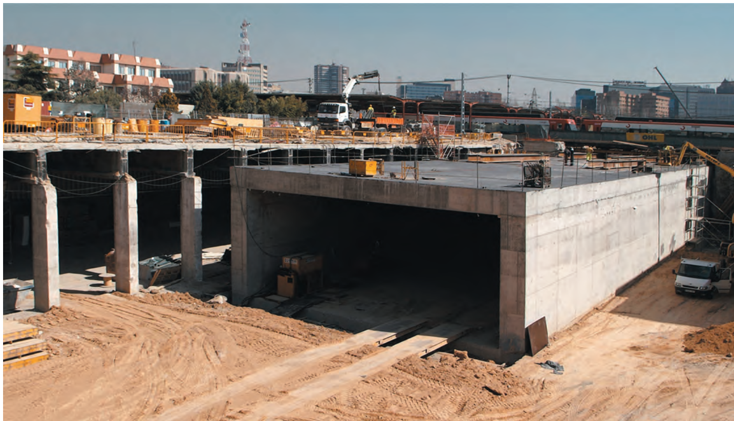
Fig. 22. Vista del empuje oeste / General view of West jacking.
