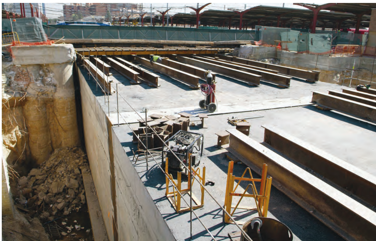
Fig. 16. Empuje Oeste. Vista de vigas de maniobra / West jacking. Manoeuvre beams.
