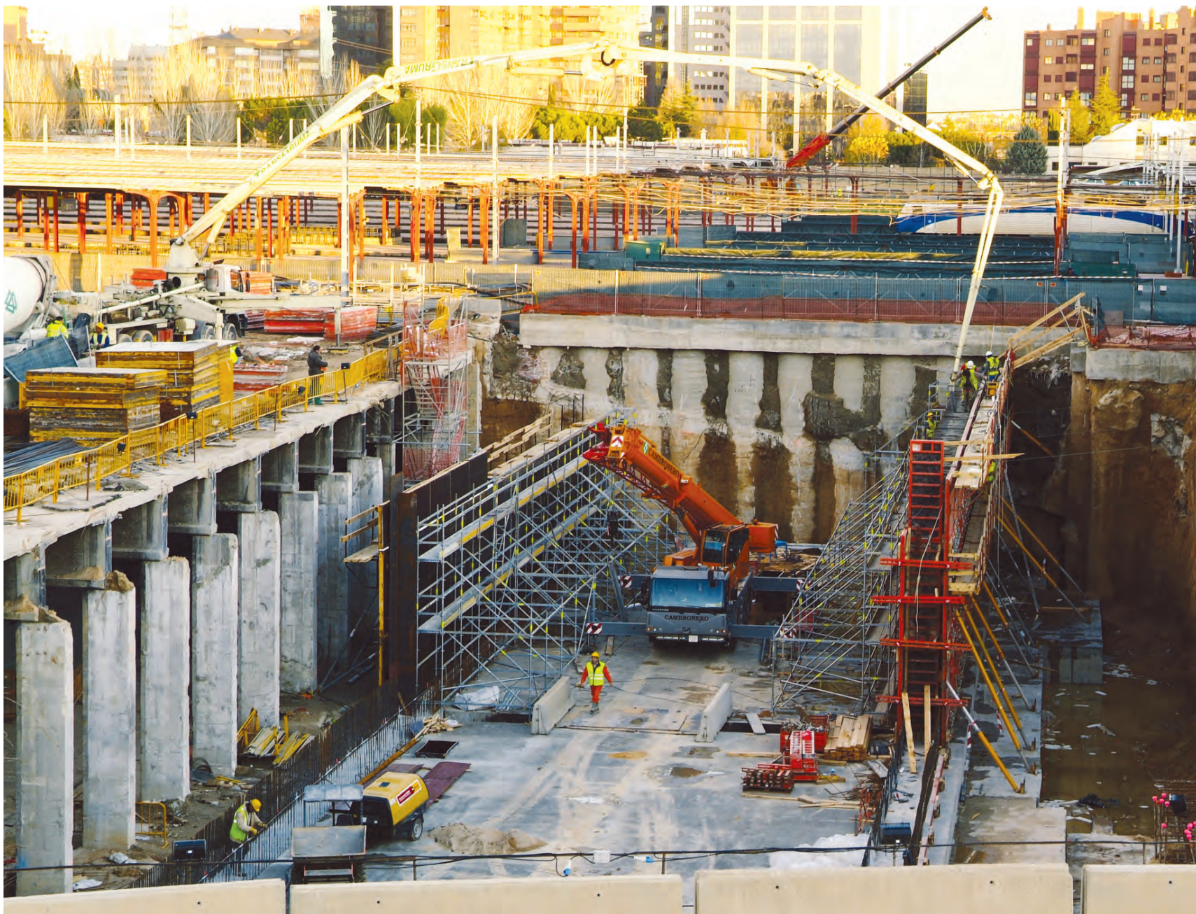
Fig 18. Foso Oeste. Homigonado de hastiles: Cajón nº1 // West pit. Construction of box nº1.
