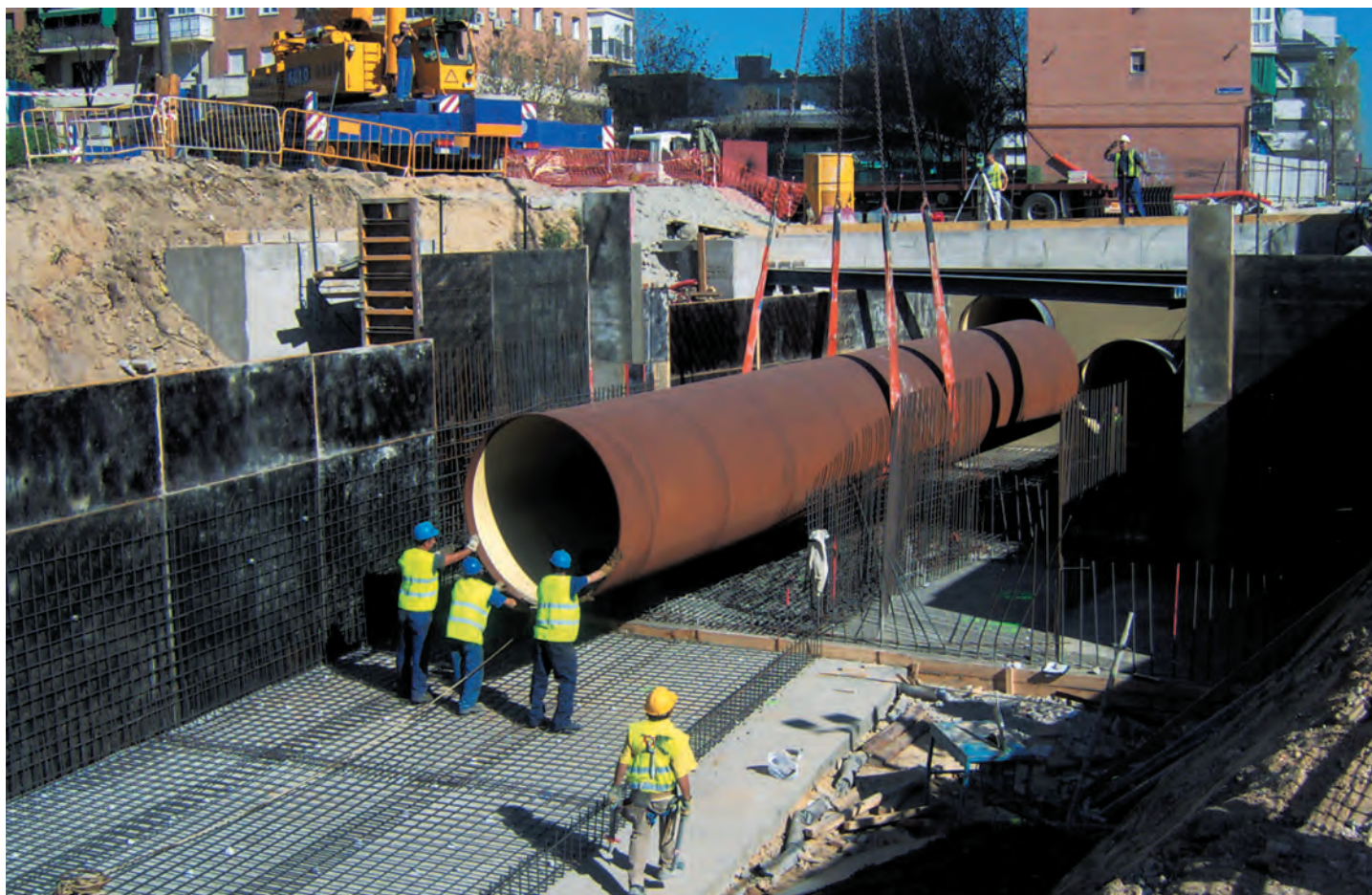
Fig. 5. Colocación de tuberías CYII / Installation of the new water pipes.
