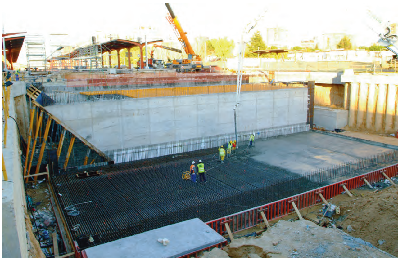
Fig. 23. Foso Este. Construcción cajón nº2 / East pit. Construction of box nº2.
