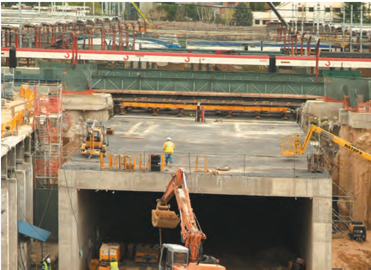
Fig 10. Empuje de cajones. Vista general / Box Jacking. General View.
