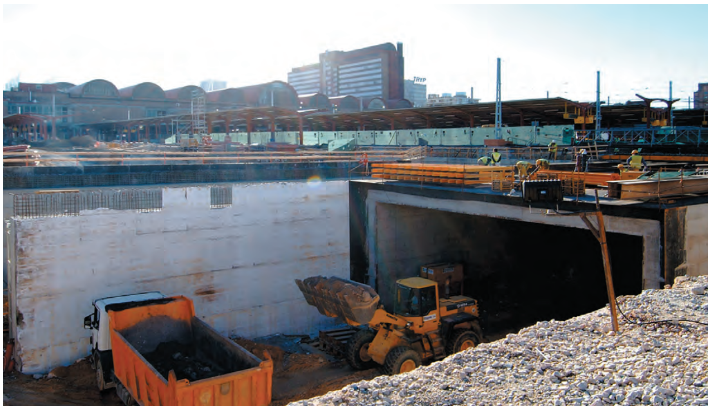
Fig. 24. Foso Este. Empuje cajón nº1 / East pit. Jacking of box nº1.
