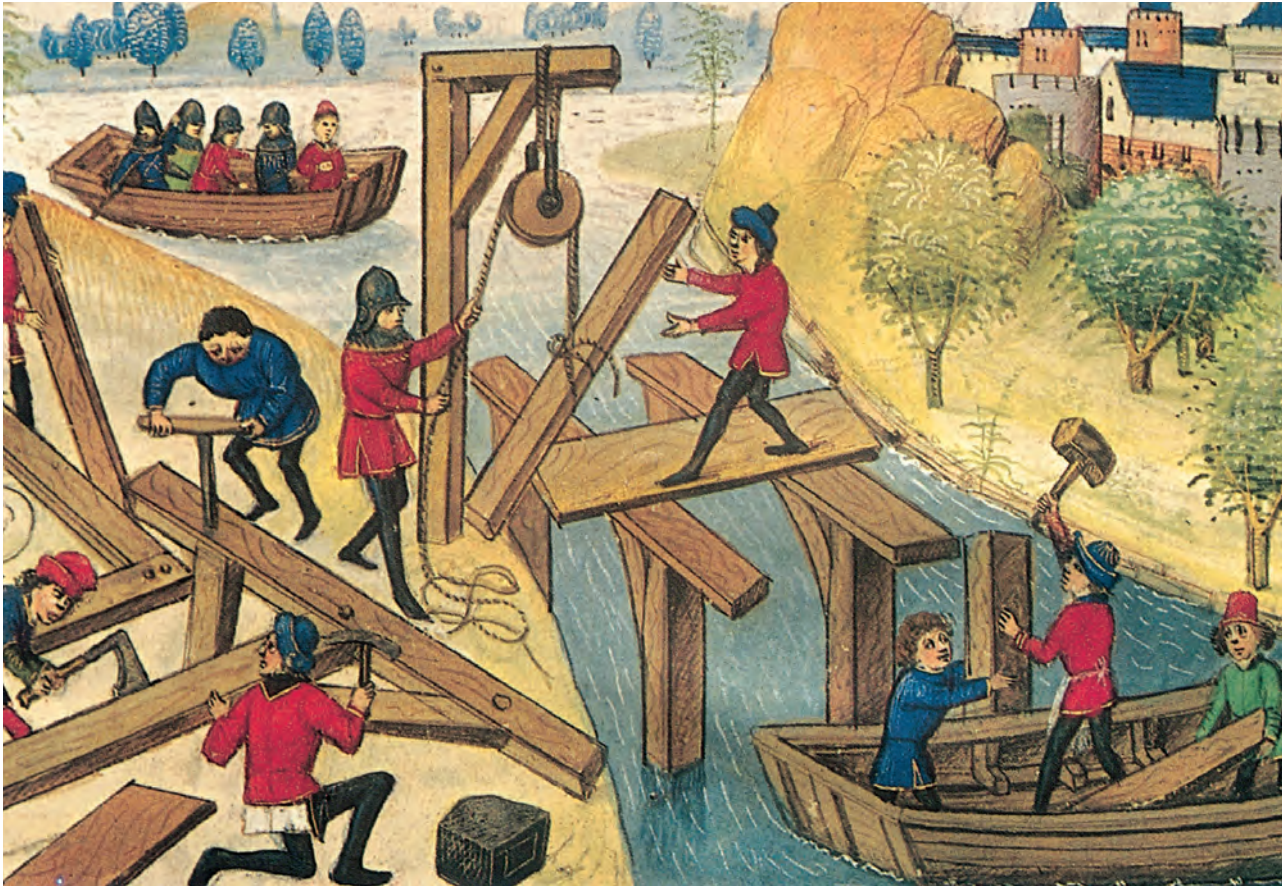
Construcción de un puente. Miniatura del Roman d'Alexandre.
