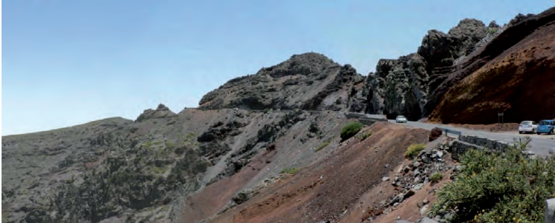
Fig. 9. Carretera LP-1 sobre la divisoria de aguas de La Caldera de Taburiente (La Palma, España) un itinerario tradicional para las comunicaciones de los aborígenes, también un itinerario para la transhumancia del pasto estacional, proporciona unas vistas de impresion sobre las cumbres de la isla así como sobre las formaciones volcánicas y sus ecosistemas relictos.
