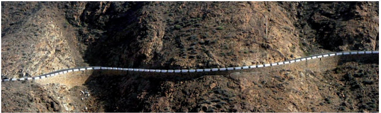
Fig. 20. Elementos tradicionales como los dientes blancos, los muros de piedra local y la disposición de la plataforma que evita el desarrollo de grandes taludes dotan de carácter a esta carretera recién construida en el siglo XXI en Fuerteventura, España (Foto I. Español).
