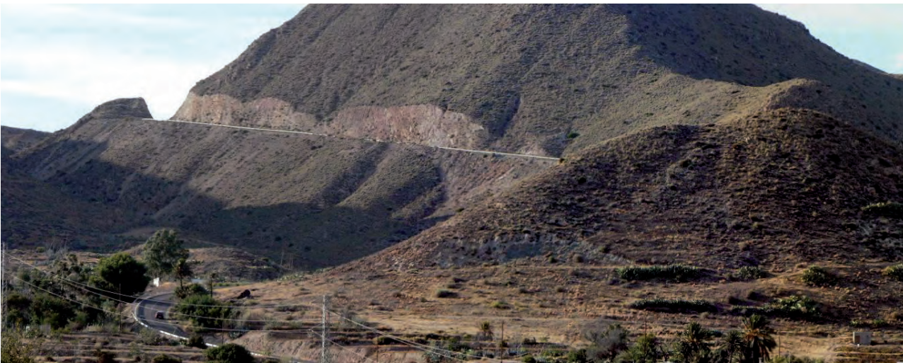
Fig. 19. Una carretera a media ladera con taludes en roca muy verticales no solo presenta un efecto estéticamente llamativo (efecto cicatriz), sino que está actuando sobre los procesos del medio (erosionabilidad, inestabilidad, contención de la biocenosis) (Foto I. Español).
