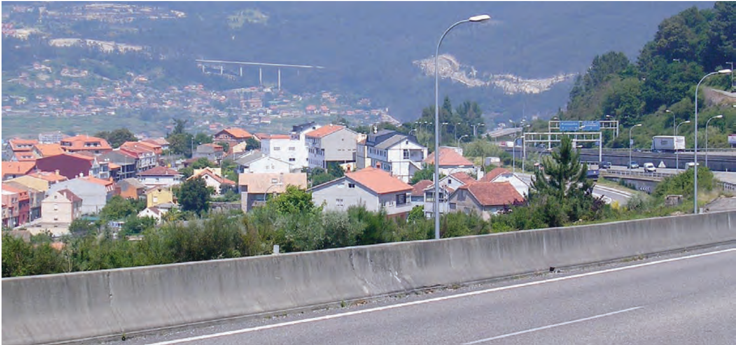
La Autopista del Atlántico construida en los años 70, y la nueva vía rápida del Morrazo en la periferia de Vigo.
