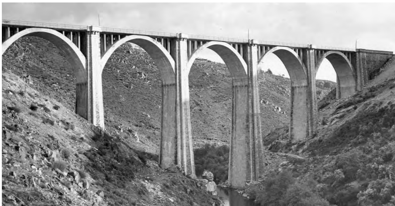
Viaducto sobre el Arnoya.
