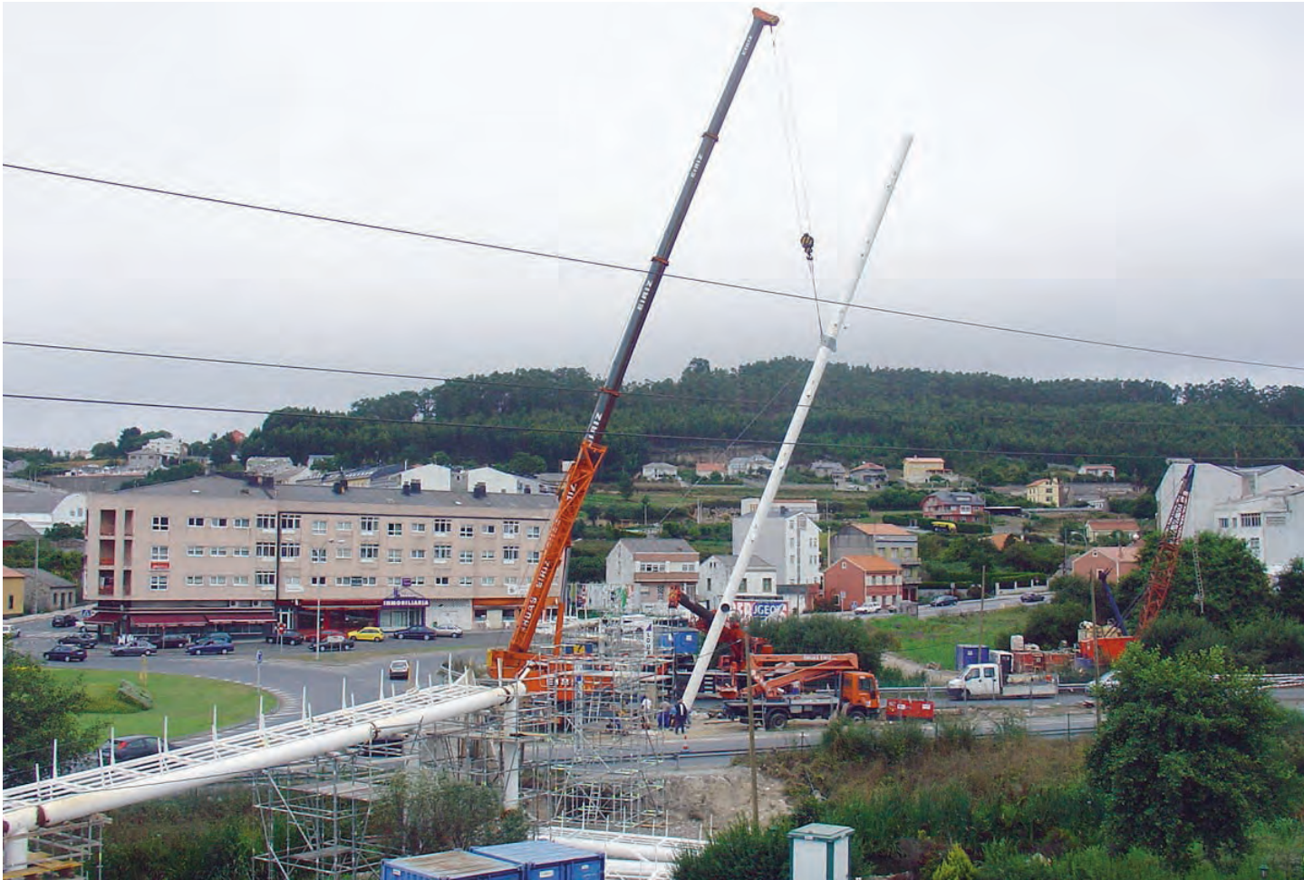
Montaje de la pila central.
