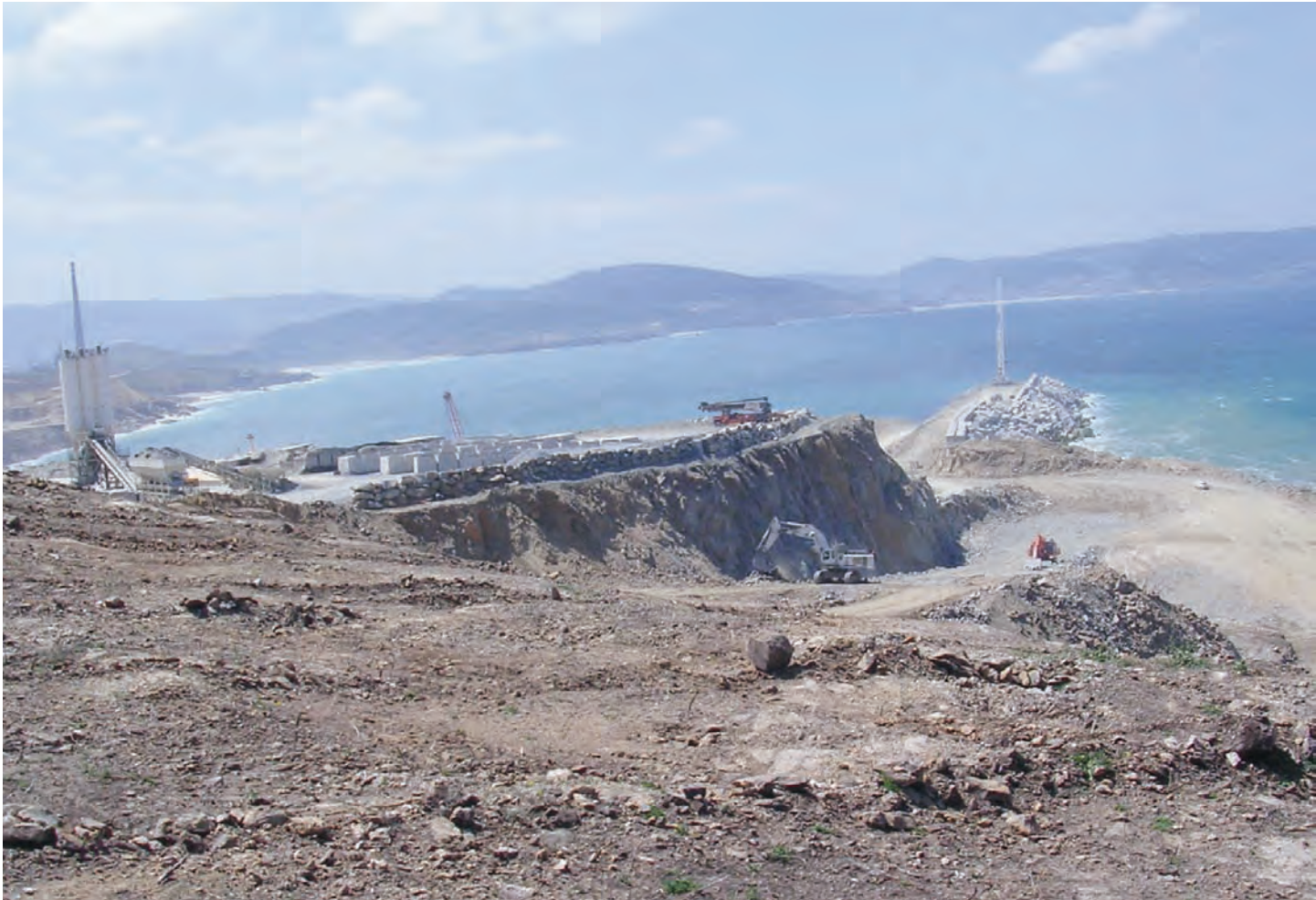
El comienzo de las obras del puerto exterior en Punta Langosteira en La Coruña.
