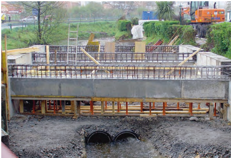
Ejecución del estribo lado Arteixo sobre el cauce fluvial.
