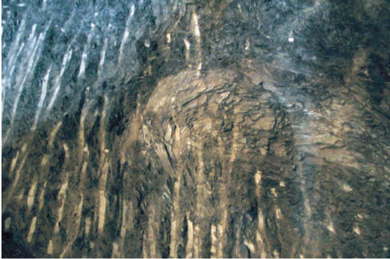
Fig.7. Pliegue de pizarras en el frente de excavación de la galería/Fold of shale at the excavation face of the access tunnel.
