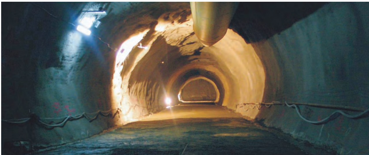
Fig. 11. Hormigonado de losa de solera/Concreti ng of floor slab.
