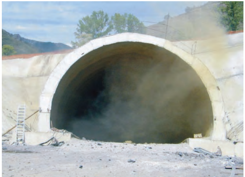
Fig.9. Detonación, extracción y ventilación/Detonation, extraction and ventilation.
