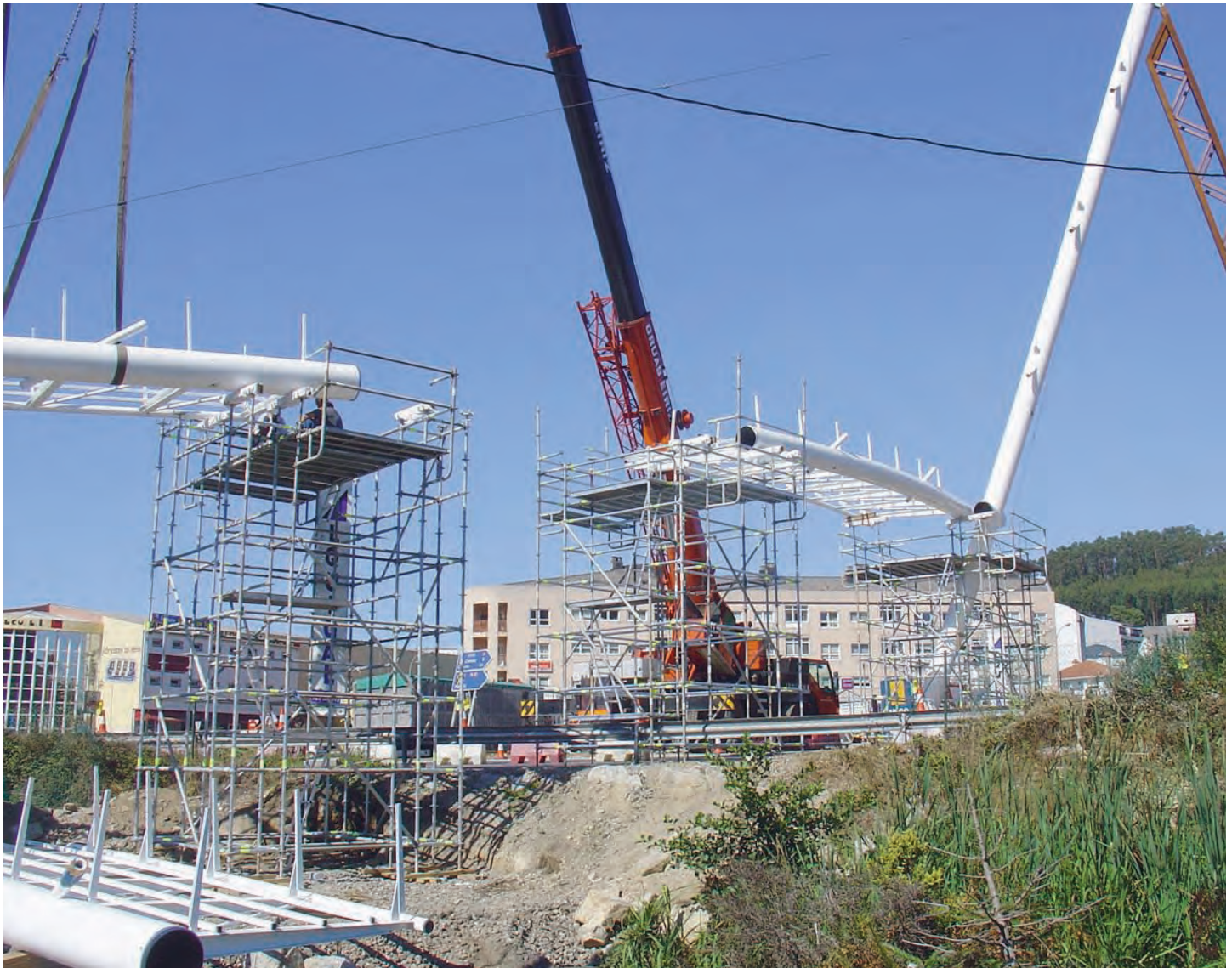
Montaje de un tramo del tablero.
