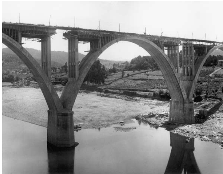
Viaducto sobre el Miño.
