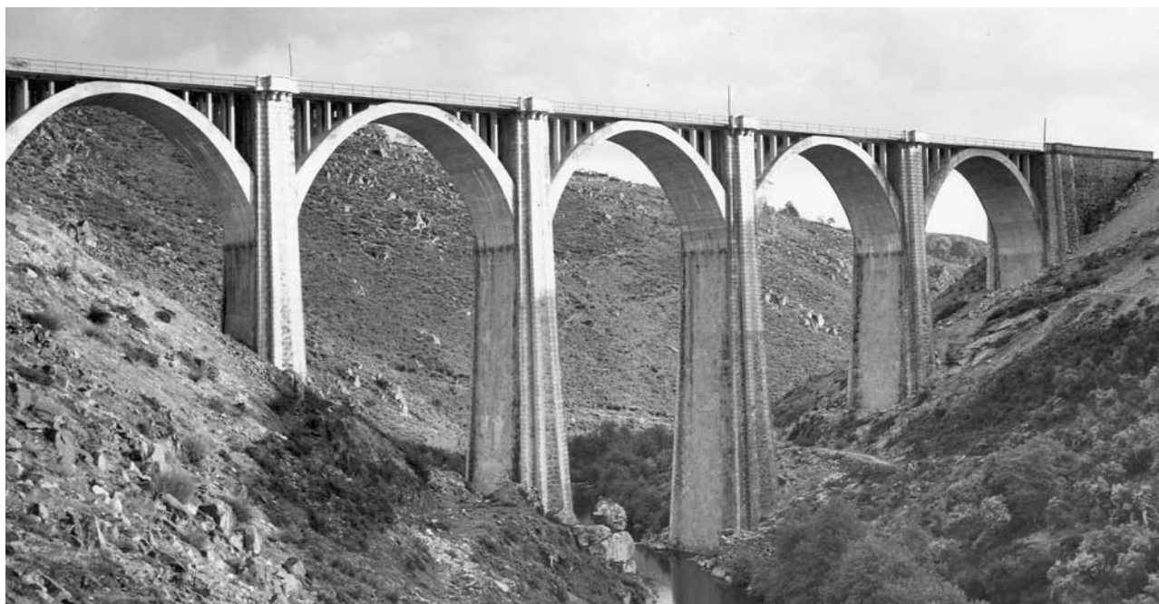
Viaducto sobre el Arnoya.
