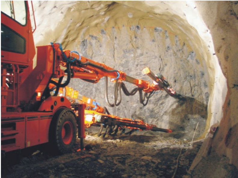
Fig. 8. Perforación de taladros para explosivos/Drilling of bore holes for explosives.
