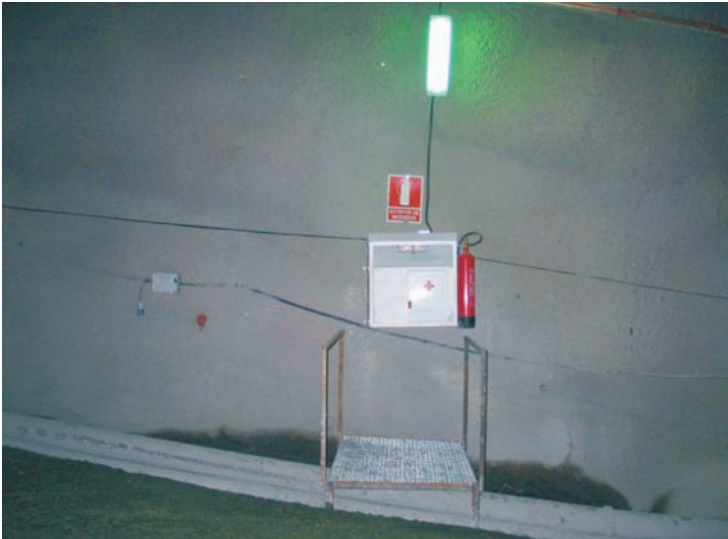
Figs. 12 y 13. Detalle de un botiquín en punto intermedio de la galería y detalle del contenedor de los detectores portátiles de gases/First-aid box at an intermediate point in the tunnel and portable gas detector box.
