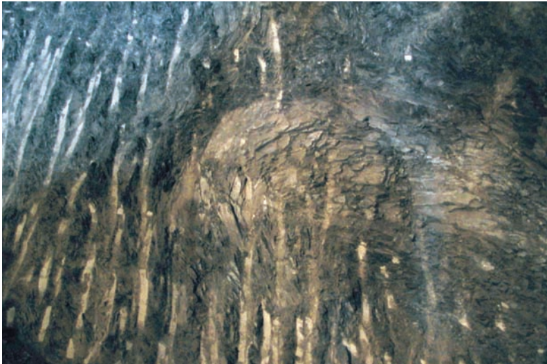
Fig.7. Pliegue de pizarras en el frente de excavación de la galería/Fold of shale at the excavation face of the access tunnel.
