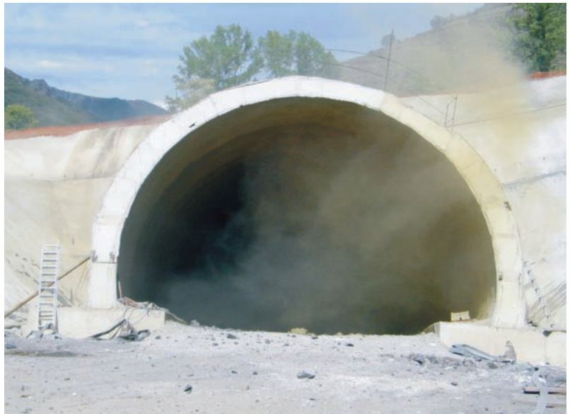
Fig.9. Detonación, extracción y ventilación/Detonation, extraction and ventilation.
