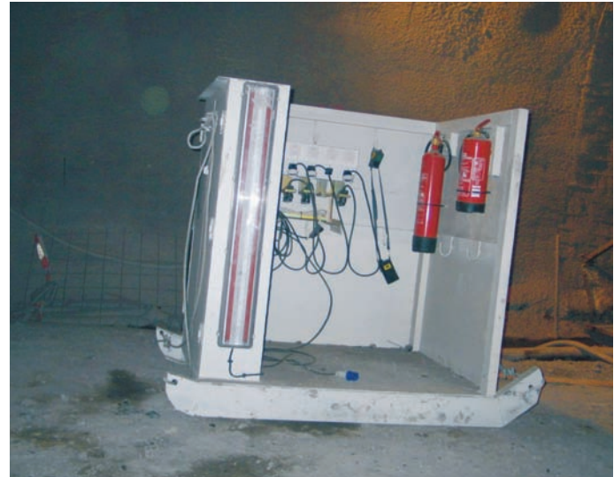
Figs. 12 y 13. Detalle de un botiquín en punto intermedio de la galería y detalle del contenedor de los detectores portátiles de gases/First-aid box at an intermediate point in the tunnel and portable gas detector box.
