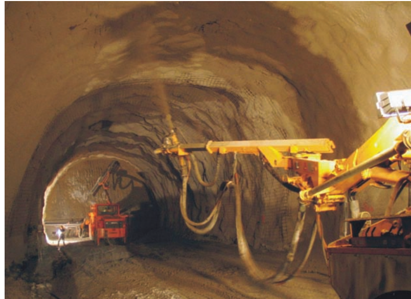
Fig. 10. Aplicación del espesor de sostenimiento y bulonado / Application of shotcrete.
