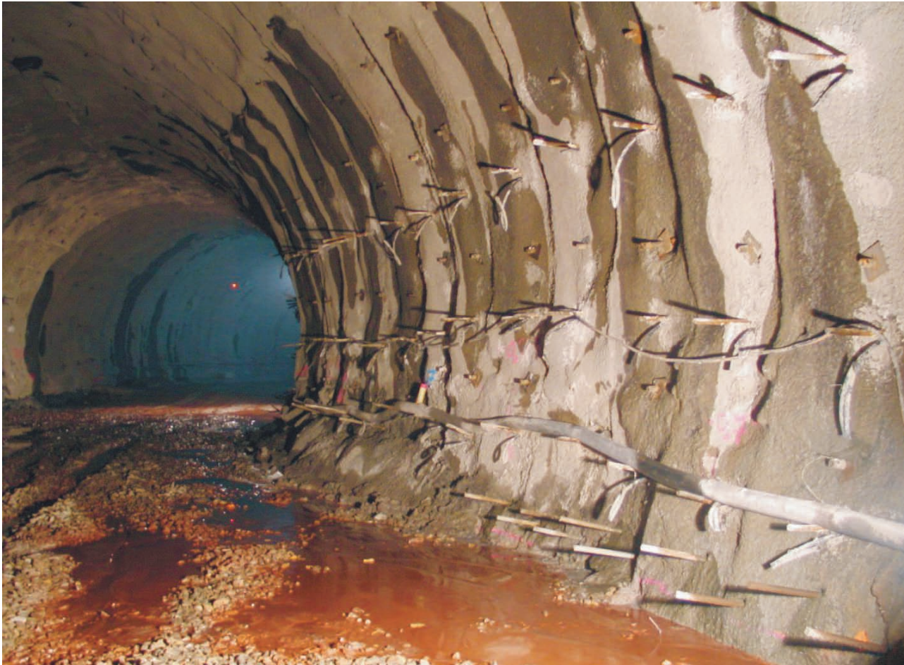
Fig. 15. Refuerzo mediante bulones autoperforantes de 9 m en la base de los hastiales de la galería/Reinforcement with 9 metre self-drilling rock bolts at the base of the tunnel walls..
