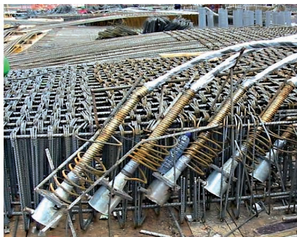
Fig. 6. Celosías mixtas de cubierta. Anclajes de pretensado de pantallas.
