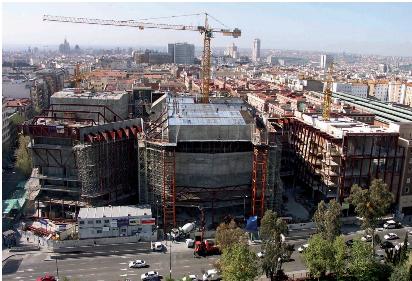
Fig. 14. Conjunto con estructura terminada.
