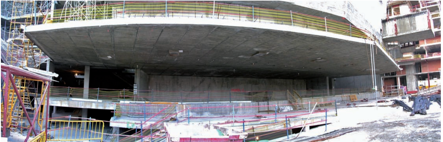
Fig. 4. Vista inferior de la gran losa volada del Teatro Principal.
