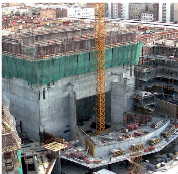
Fig. 3. Esquema e imagen de la estructura colgada del Teatro Principal.
