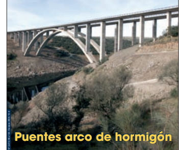
Portada: Viaducto Ayamonte-Cáceres
