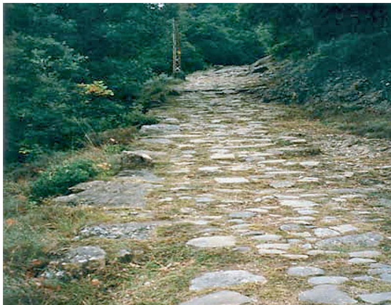
Foto 1. Capsacosta. Tramo empedrado el el pirineo oriental. (Fuente: J.M. Fonseca, J. Alonso).
