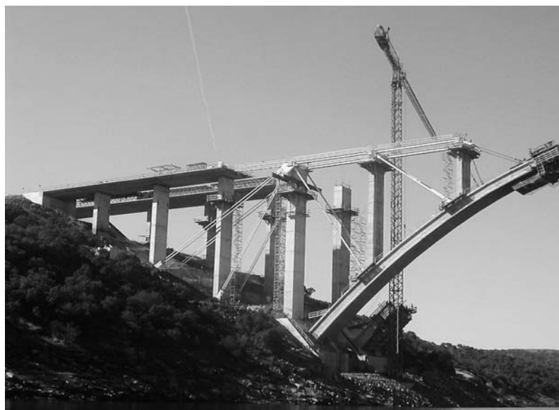
Fig. 5. Sistema de triangulación temporal.
