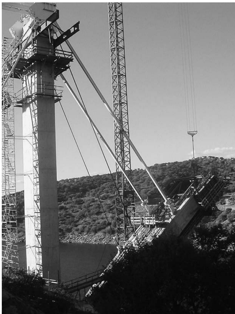
Fig. 8. Tirantes auxiliares y diagonales rígidas.
