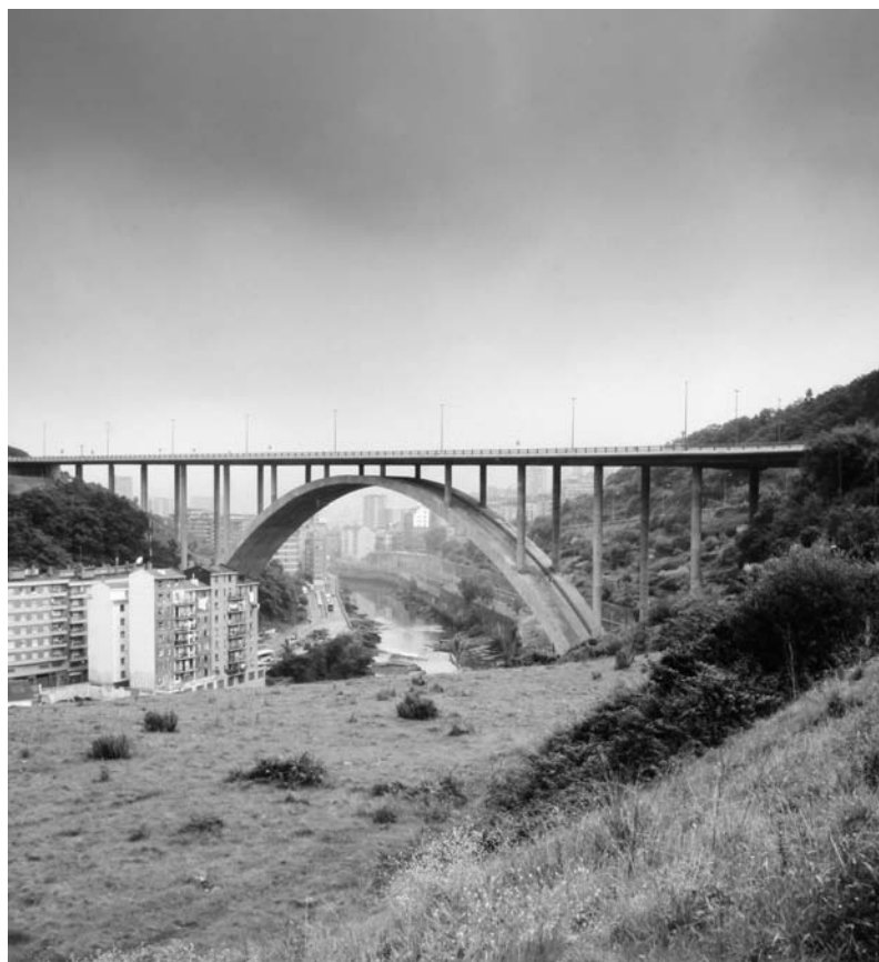
Fig. 11. Viaducto de la Peña.
