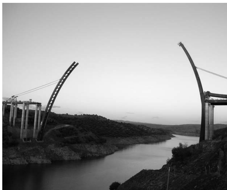
Fig. 2. Proceso de abatimiento de los semiarcos.
