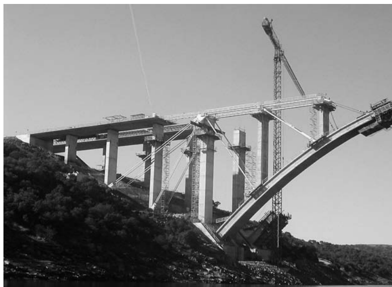
Fig. 5. Sistema de triangulación temporal.
