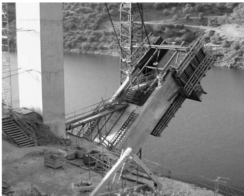
Fig. 10. Empleo de carro de avance tipo "autotrepa".
