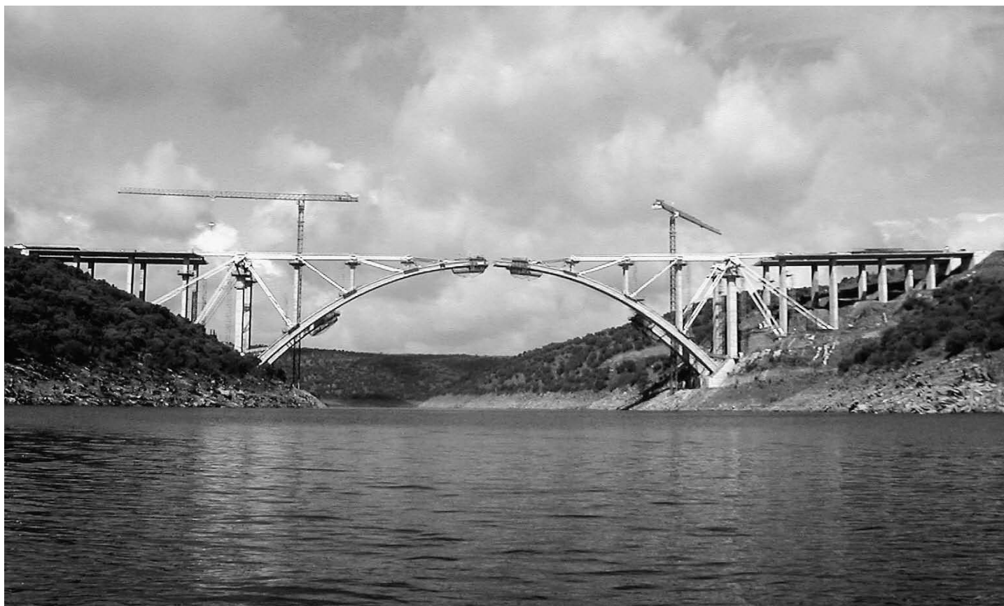
Fig. 12. Viaducto sobre el río Almonte.
