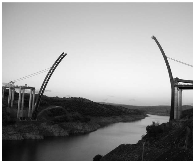
Fig. 2. Proceso de abatimiento de los semiarcos.
