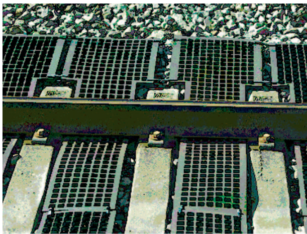
Fig.8. Protección japonesa para evitar el vuelo del balasto y el peligro a los trenes (fotos MMM).
