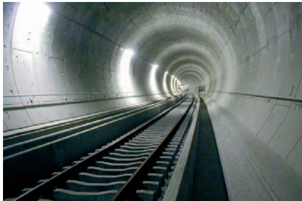
Fig. 18. Túnel revestido con dovelas prefabricadas.
