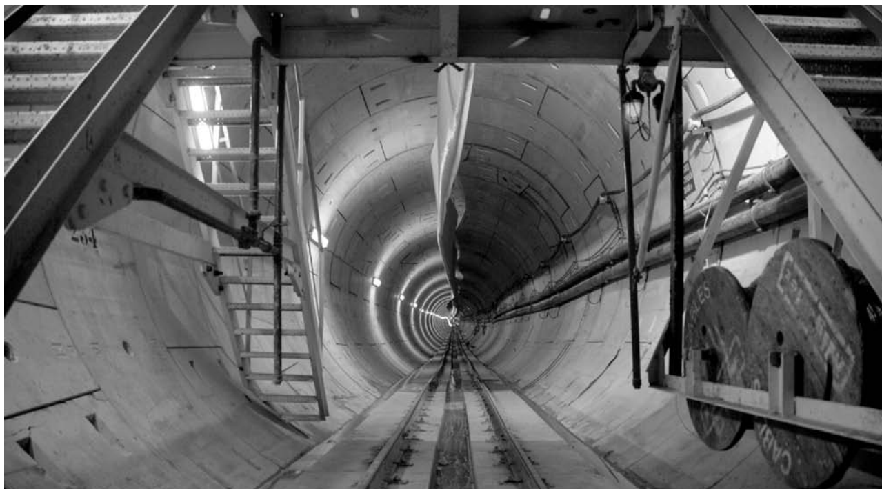
Túnel Estación Plaza de Cuba.
