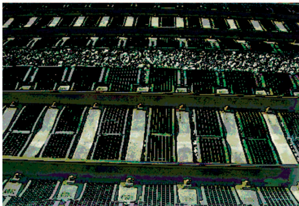
Fig.9. Aumento de espesor de balasto por descenso del terraplén y cuñas de transición. Se observa bien el descenso por la curvatura de la canaleta, que inicialmente era horizontal.
