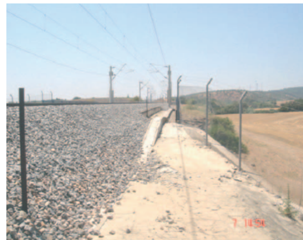
Fig.9. Aumento de espesor de balasto por descenso del terraplén y cuñas de transición. Se observa bien el descenso por la curvatura de la canaleta, que inicialmente era horizontal.
