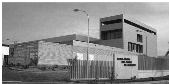
Desaladora Canal de Alicante.
