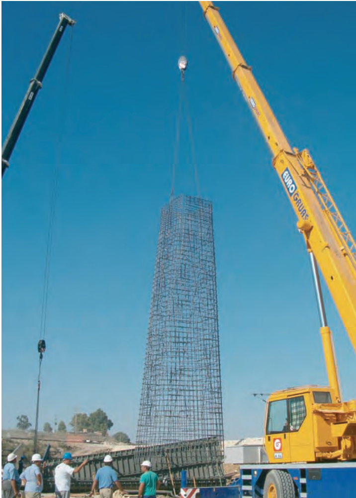
Izquierda, colocación de fuste completo ferrallado, a la derecha, encofrado.
