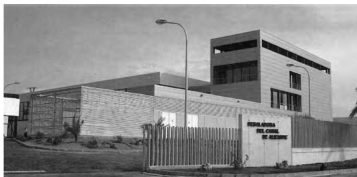
Desaladora Canal de Alicante.
