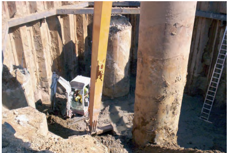
Trabajos de excavación de un encepado, dentro del cauce del Guadalquivir, de 5 pilotes de D=2.000 mm.
