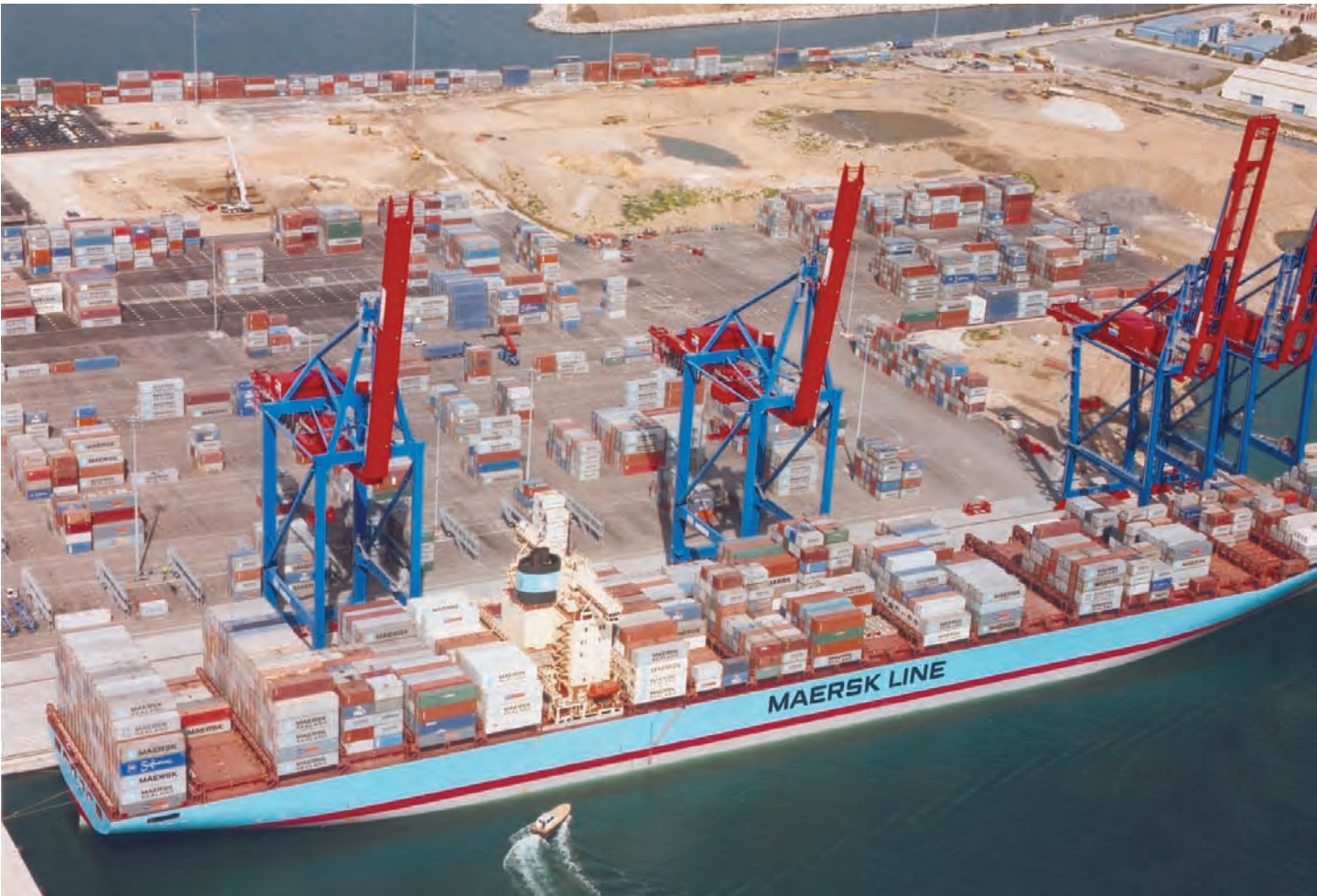
Terminal de Contenedores del Sudeste, Málaga.
