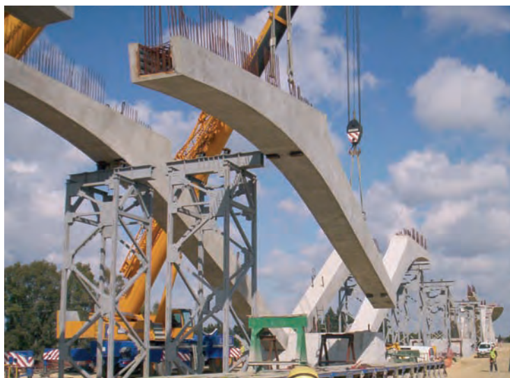
Arriba, montaje de vigas en Tramo 1, dentro de Balsas de Azucarera El Portal. Abajo izquierda, detalle cogida semiarco prefabricado interior, en Tramo 4. Abajo derecha, colocación de semiarco prefabricado interior, en Tramo 6. Se pueden observar las torretas metálicas provisionales y al fondo los caballetes guía de apoyo en las rótulas.
