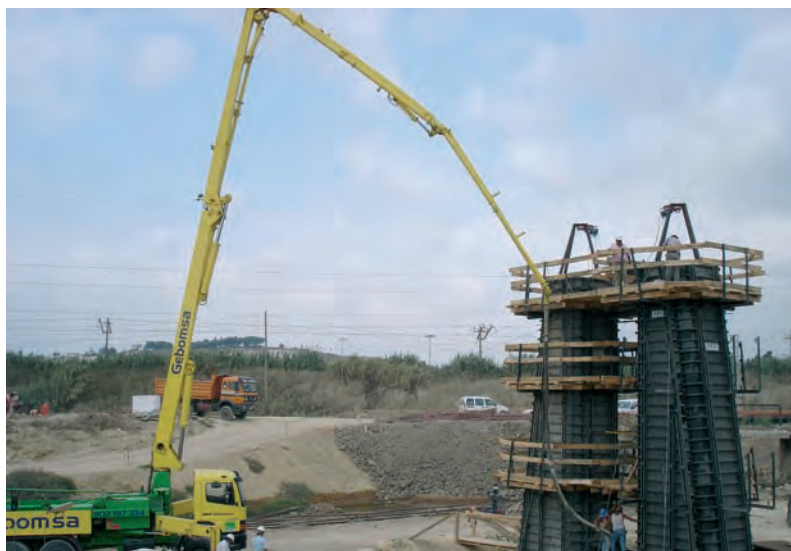
Hormigonado en una fase, abajo, desencofrado.
