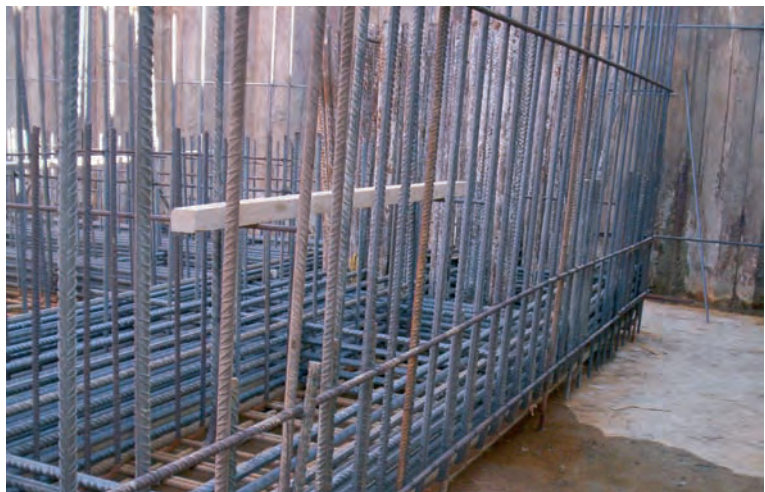
Detalle armado parrilla inferior de un encepado de tramo hiperestático. Hasta 8 capas de D=32 mm.
