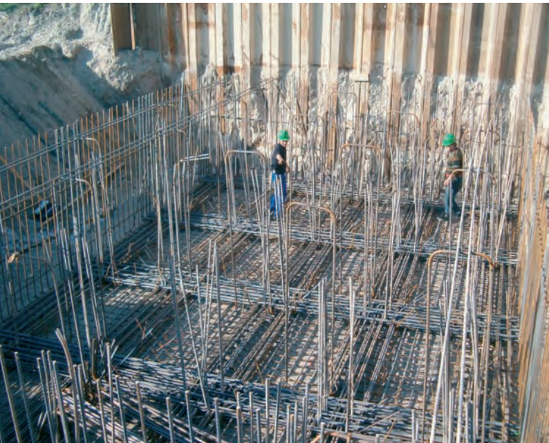
Ferrallado encepado Pila Tramo 1.
