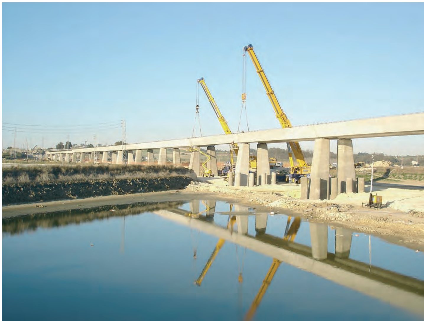
Arriba, montaje de vigas en Tramo 1, dentro de Balsas de Azucarera El Portal. Abajo izquierda, detalle cogida semiarco prefabricado interior, en Tramo 4. Abajo derecha, colocación de semiarco prefabricado interior, en Tramo 6. Se pueden observar las torretas metálicas provisionales y al fondo los caballetes guía de apoyo en las rótulas.
