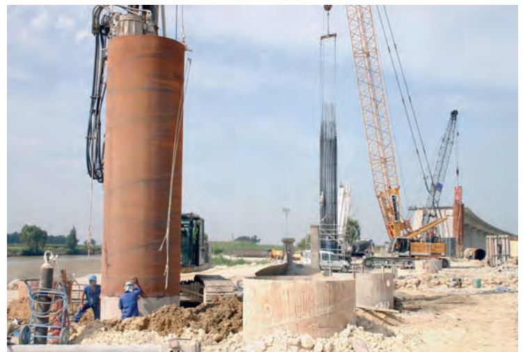
Izado de un tramo de 24 m de ferralla para un pilote de D=2.000 mm. A la derecha, distintas fases del pilotaje del Tramo 6. En primer plano trabajos de perforación y soldadura de tramos de camisa perdida. Al fondo colocación de la jaula de ferralla en un pilote de D=2.000 mm.
