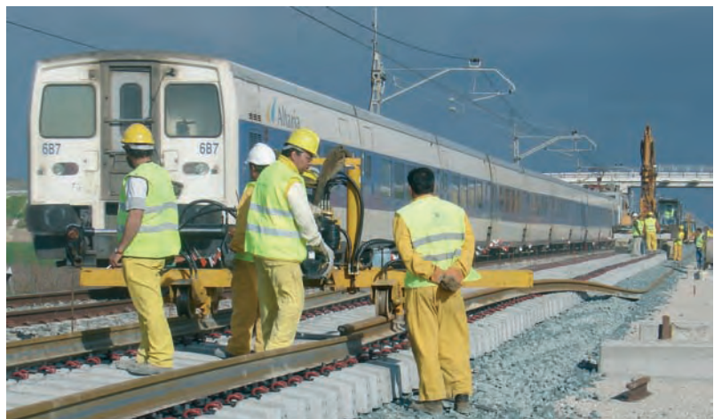
Montaje de vía 1 en los tres últimos kilómetros del tramo. Vía actual en servicio.
