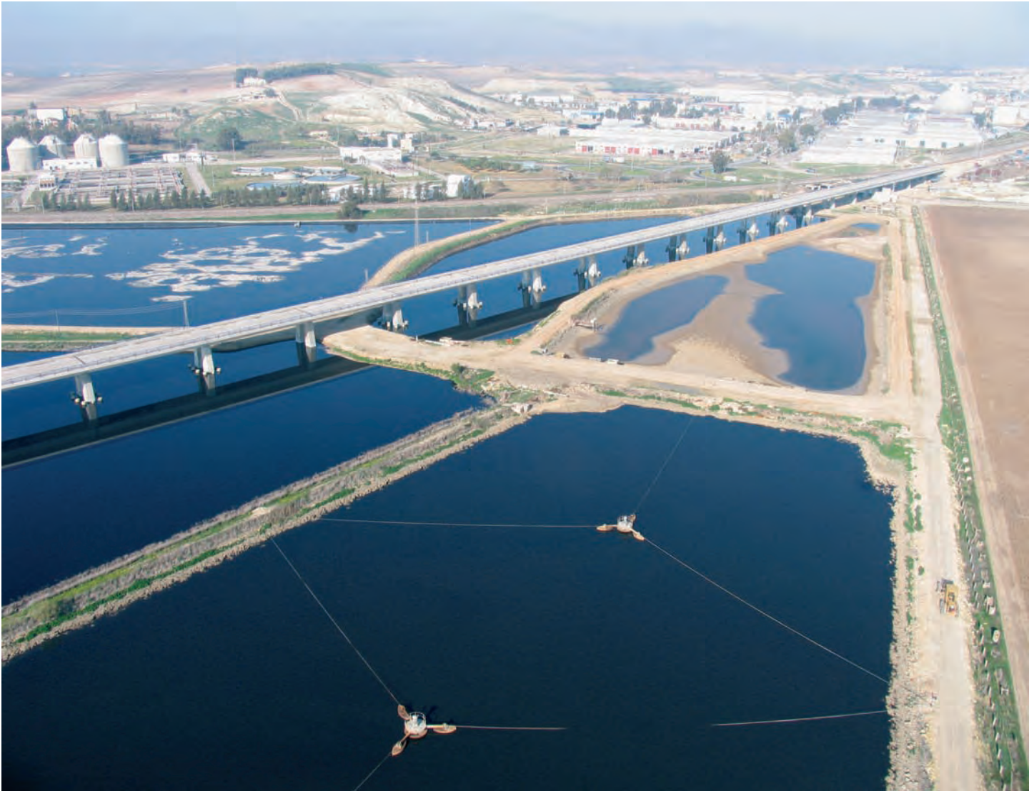
Tramo 1 ejecutado y en servicio las Balsas de Azucarera El Portal.
