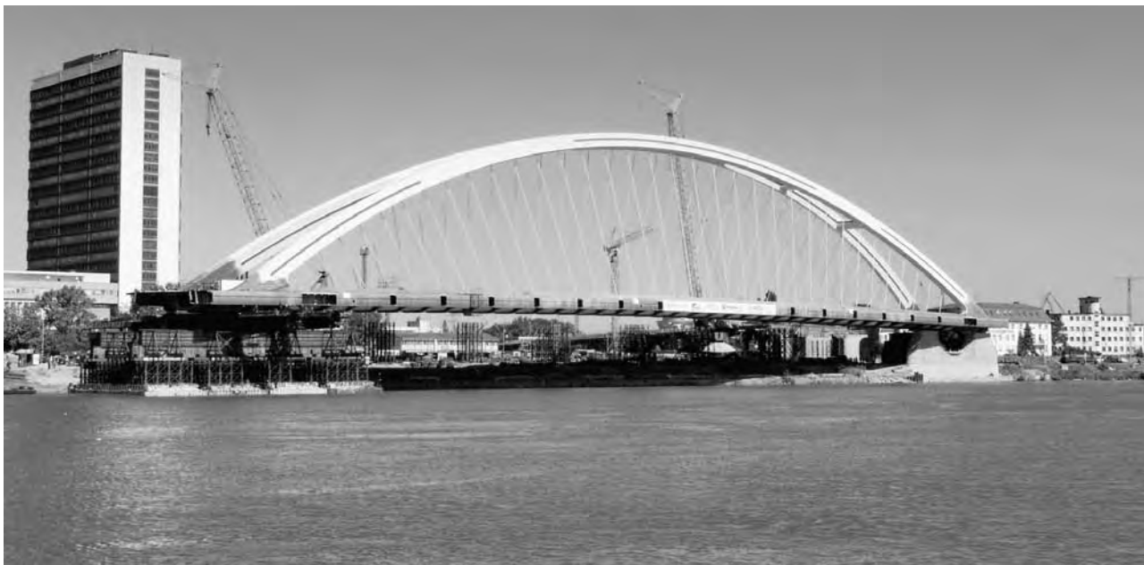
Fig. 1. Desde hace más de 40 años los sistemas DSI de postesado han demostrado su calidad en obras tan impresionantes como el Puente Apolo en Bratislava (Eslovaquia)/ DSI post-tensioning kits have shown proven quality for over 40 years in impressive construction works such as the Apollo Bridge in Bratislava (Slovakia).
