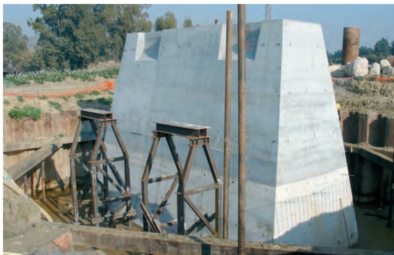
Plinto de apoyo de semiarcos. En la parte superior se observan los huecos en los que se materializa la rótula.
