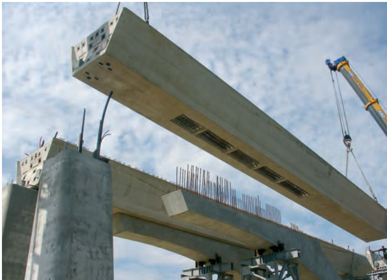
Montaje de viga exterior de un tramo hiperestático. Obsérvense las ventanas en la parte inferior de la viga para enhebrar las esperas de arco. A la izquierda se pueden ver los torones de 12 Ø 0,6" correspondientes al postesado vertical listos para enhebrar en las vainas de la viga.
