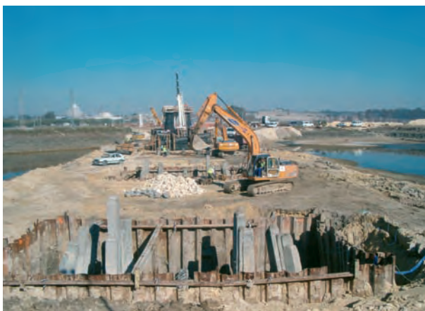
Ejecución de encepados pilotados con pilotes prefabricados hincados, dentro de Balsas Azucarera El Portal.
