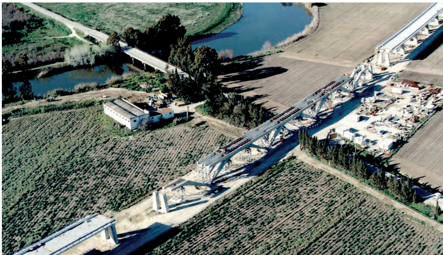
Vista aérea Tramo 4. Montados los arcos prefabricados y las vigas. Ejecutándose los macizos de conexión arcos-vigas. Abajo, vista aérea Tramo 6. Montados los arcos prefabricados. En fase de montaje las torretas provisionales sobre pilintos.
