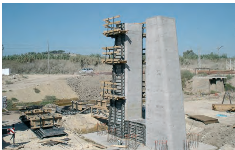
Hormigonado en una fase, abajo, desencofrado.
